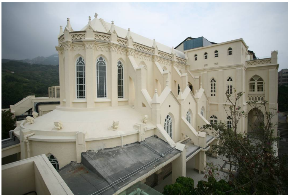
新哥德式小教堂連外牆飛扶壁及其後面療養院大樓的外觀
