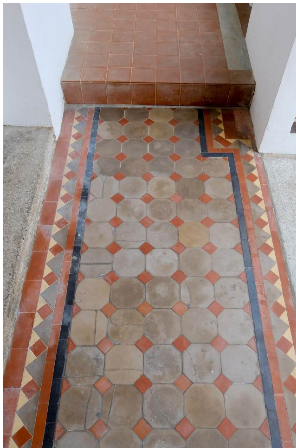
北立面遊廊的舊地磚
