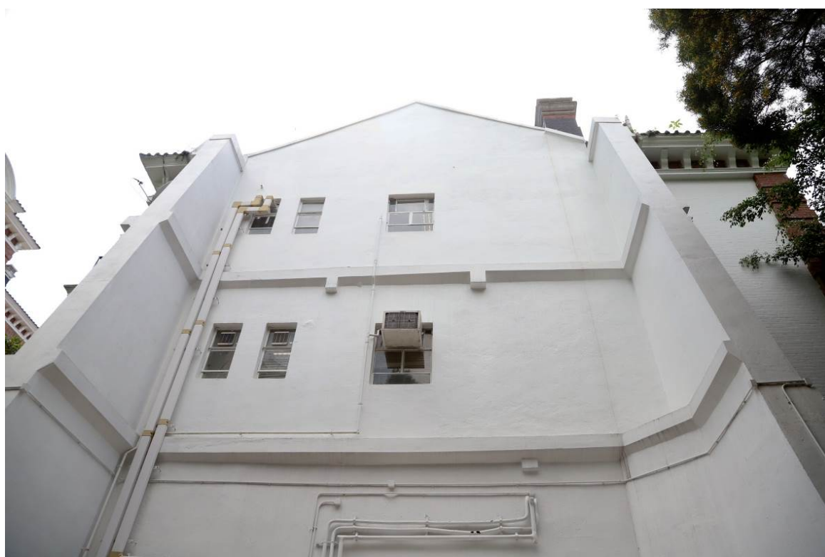
一九六六年發生嚴重山泥傾瀉後，倒塌部分加建兩道扶壁
