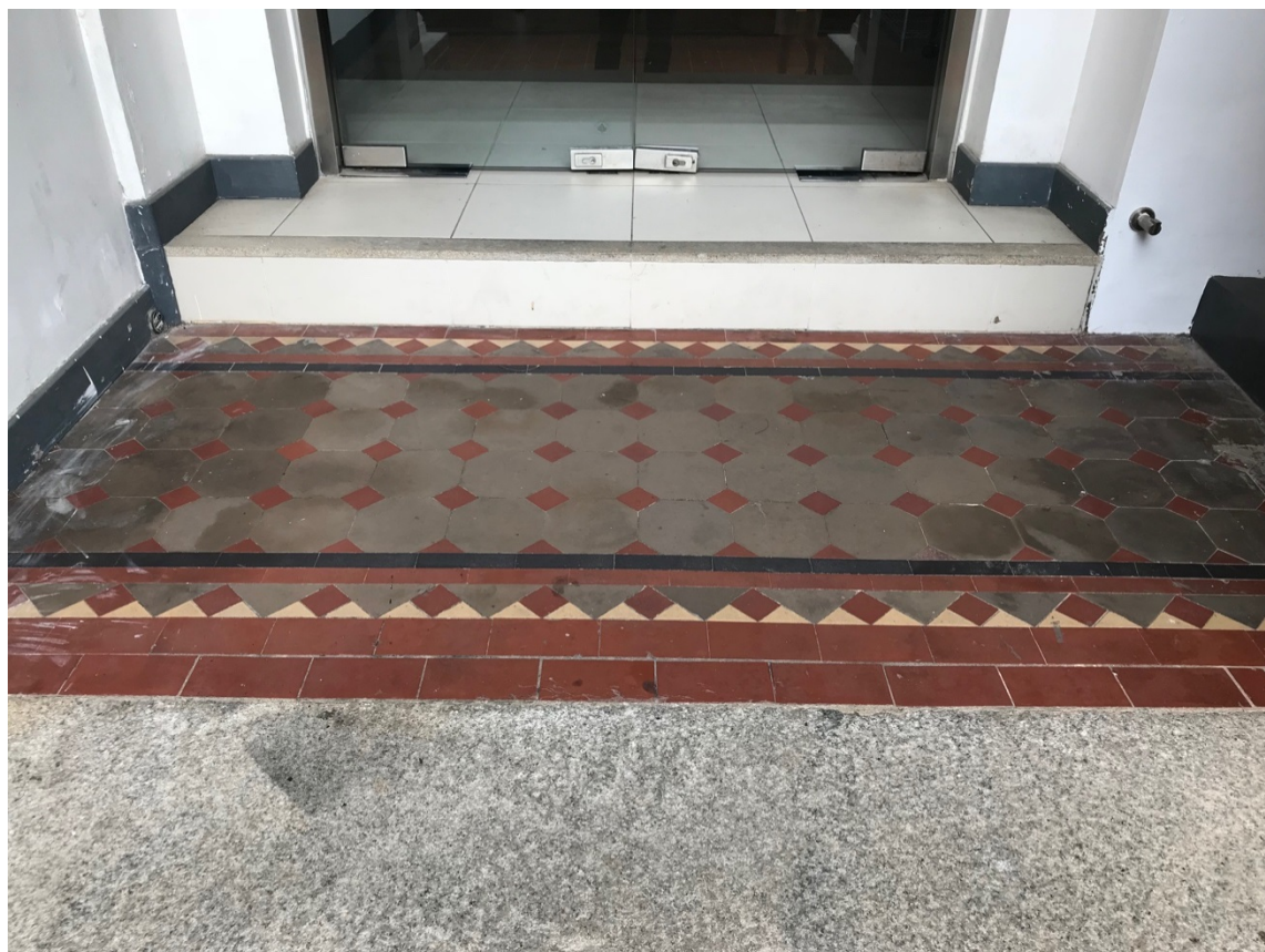
北立面遊廊的舊地磚
