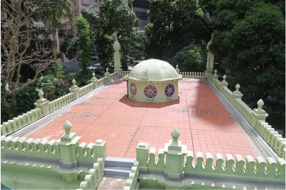
屋頂護牆飾有圓形城齒裝飾，每隔一段距離所設的座墩頂有尖飾。
