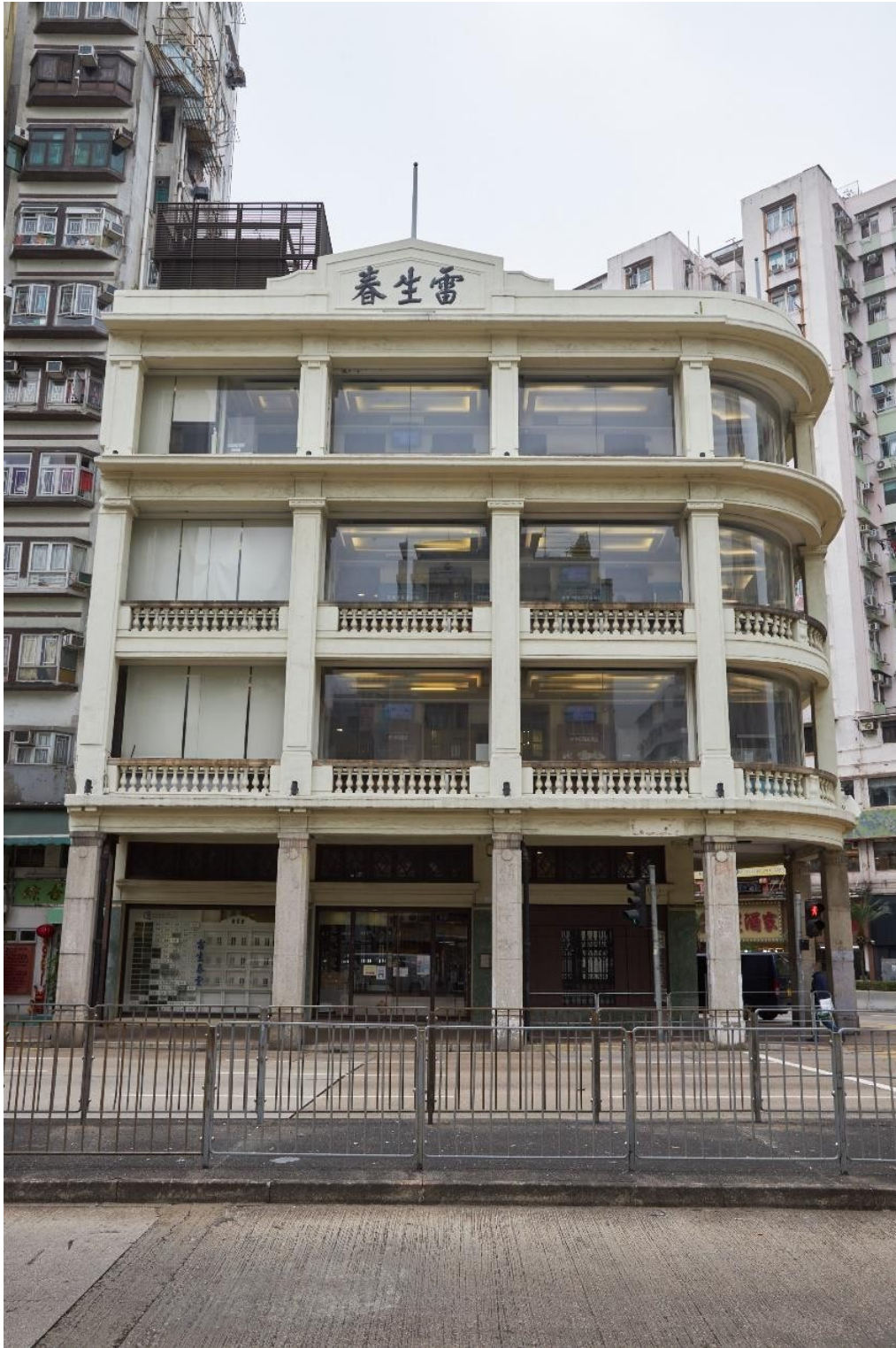
雷生春面向荔枝角道的側立面， 可見弧形設計、長方形框架和有設計特色的欄杆。
