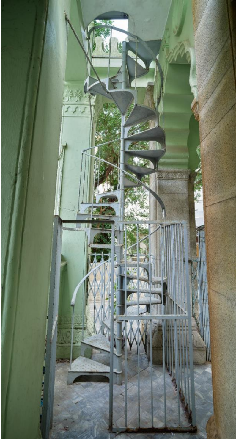
正門門廊角落處通往宣禮塔的金屬旋轉樓梯。
