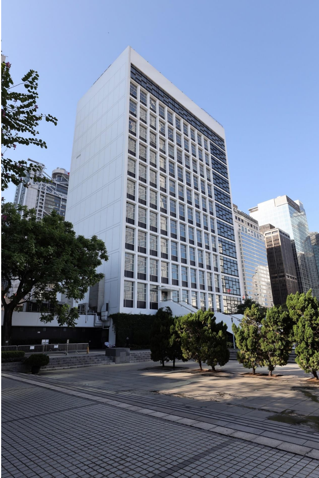
高座北立面外牆為「混凝土框架內簡單而具規律性的窗戶排列」，東立面外牆則以白色批盪。
