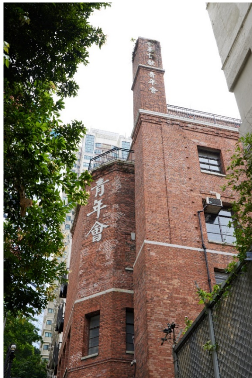
從樓梯街望向大樓的側立面和背立面， 基督教青年會的中文名稱設於大樓的顯眼位置。
