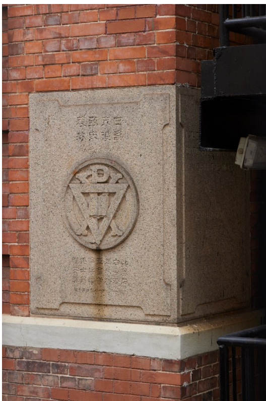
置於大樓正立面的奠基石
