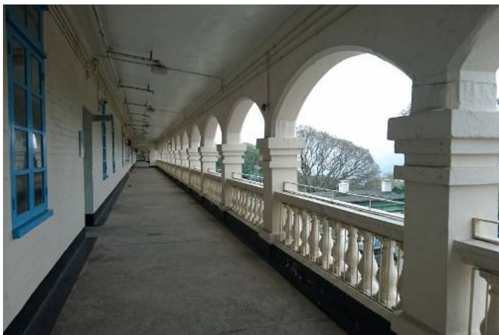
遊廊上的托斯卡納式支柱、古典甕形扶欄和花崗岩蓋頂石。
