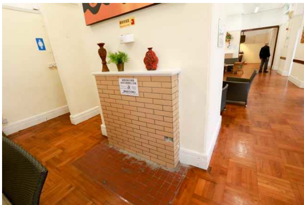
磚砌壁爐腔現已用磚圍封。地板尚存部分舊有紅色缸磚。
