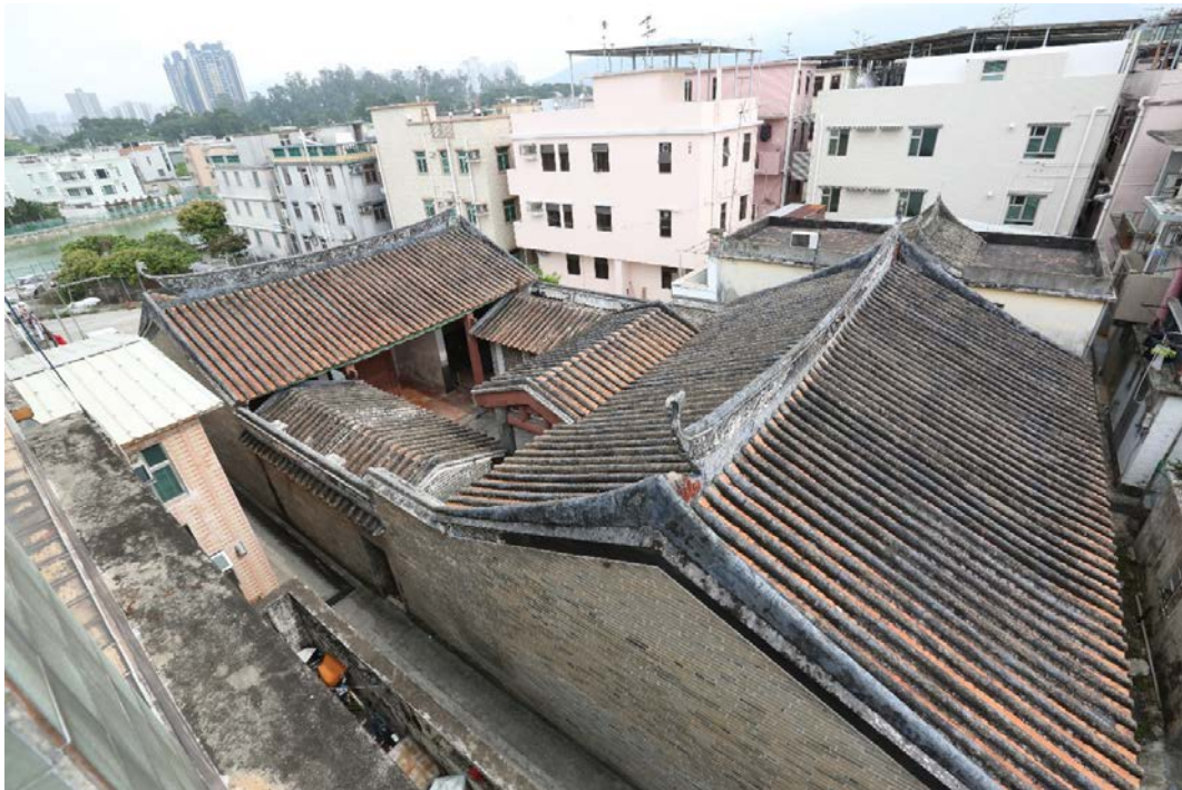
兩進三開間布局，後進的門廊築有捲棚頂
