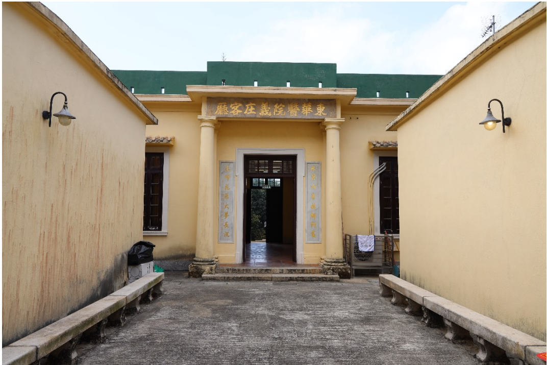
客廳背面 門廊由一對托斯卡納式圓柱及壁柱支撐
