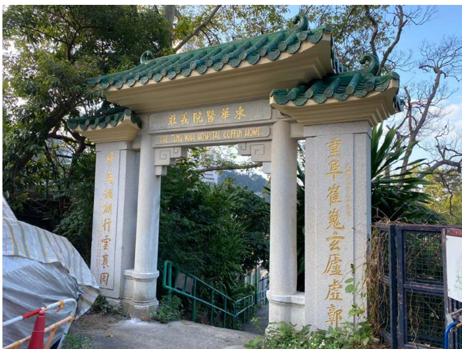
義莊位於域多利道附近的中文牌樓 牌樓由花崗石建造及有水刷石飾面，綠色琉璃瓦頂飾有正吻及模塑簷楣。
