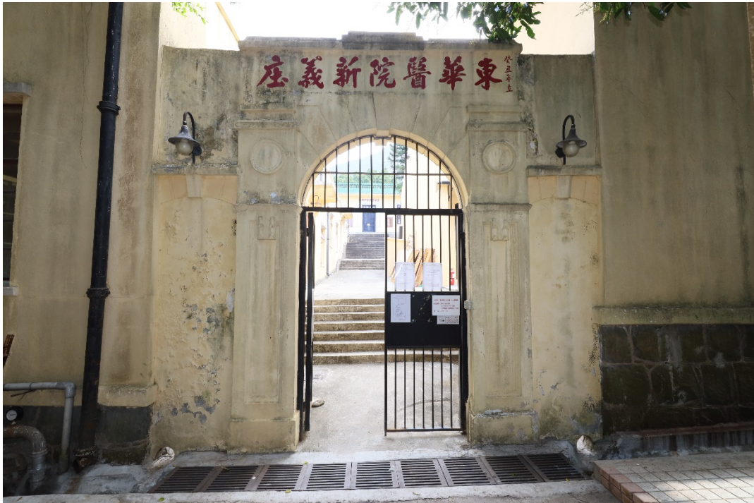
義莊西面入口建於一九一三年 中央通道口飾有模塑拱楔、拱頂石及一對裝飾壁柱。
