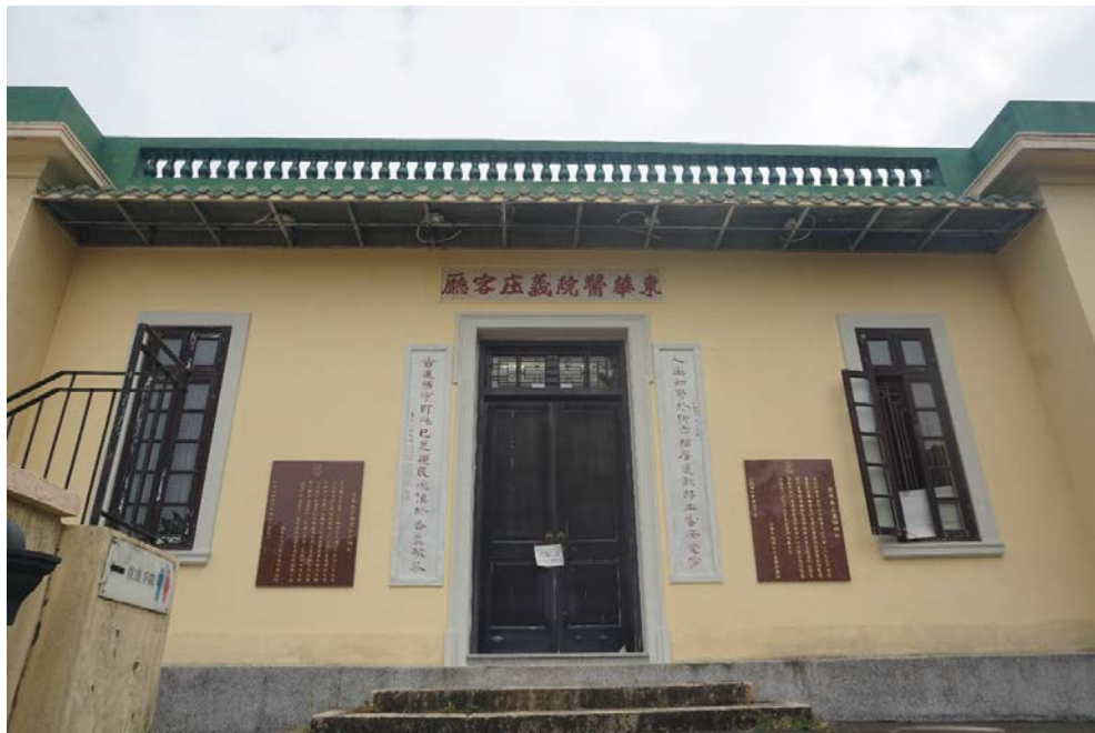
客廳正面 混凝土平屋頂上的護牆飾有花瓶形欄杆
