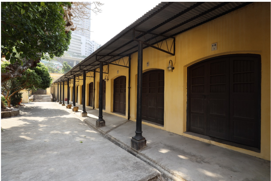
「壽」字莊房前方的遊廊由鐵製支柱及托架支撐
