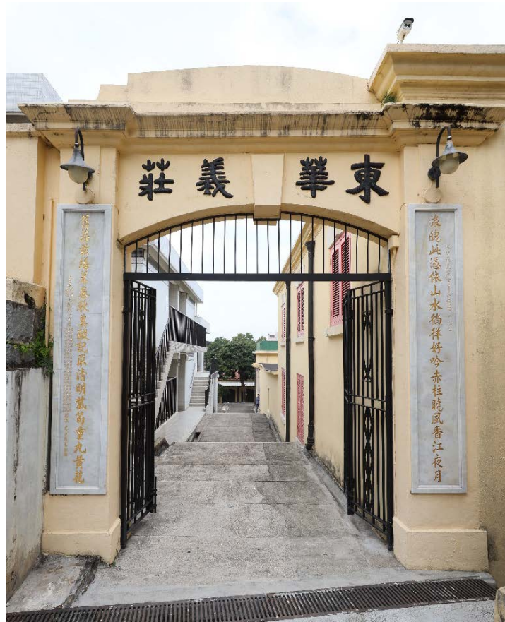
義莊的西式平圓拱牌坊 牌坊頂部飾有簷楣，上有略帶弧形的山牆。 拱頂石兩邊分別飾有「東華」及「義莊」的浮雕字。
