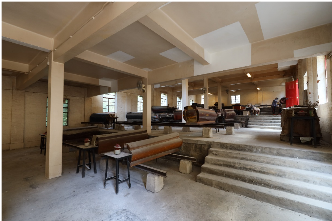
新大堂內部 由方柱支撐的混凝土平頂建築
