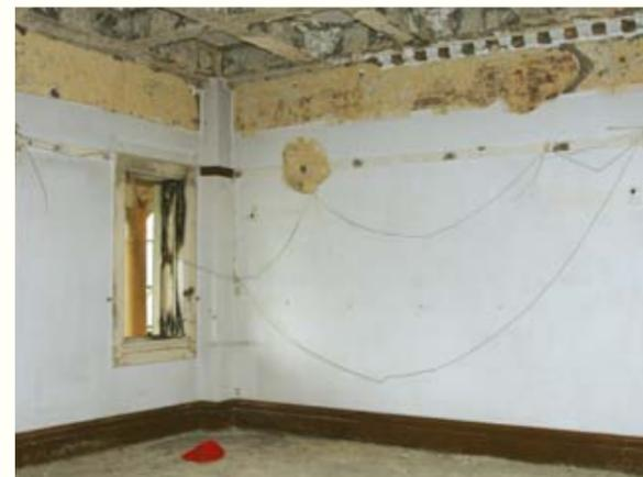
圖 8. 室內大量掛鏡線被拆除
