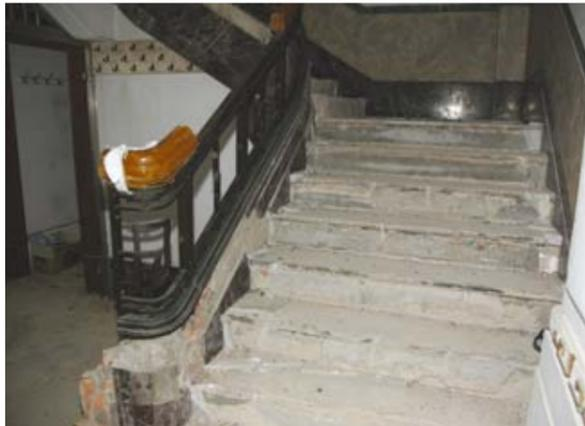
圖 28. 雲石踏面和踢面全被破壞
