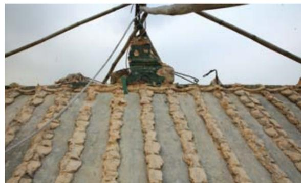
圖 115. 架空鋪瓦的沙漿排列原狀
