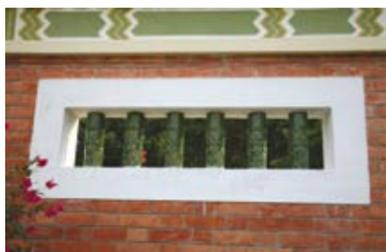
圖 118. 內圍牆漏窗的琉璃竹節筒
