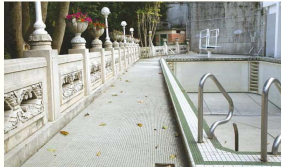
圖 25. 游泳池外側護欄輕微外傾
