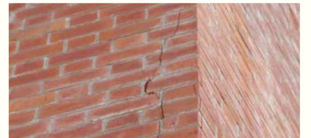
圖 10. 牆體轉角有垂直裂縫
