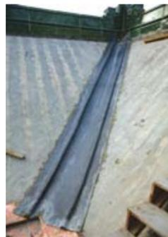
圖 57. 附加的鉛皮斜水溝
