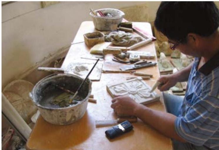
圖 128. 安裝灰塑前修補成品
