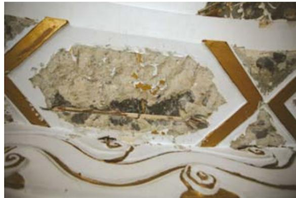
圖 65. 殘件中發現預埋竹筋的工藝
