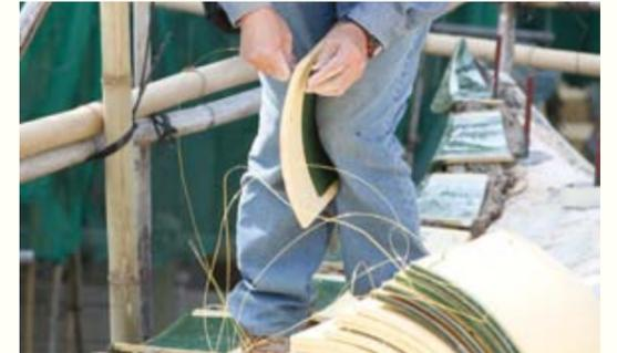
圖 116. 工人正在給瓦片穿銅線
