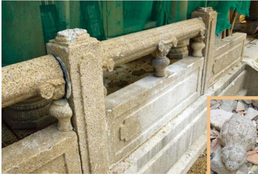
圖 20. 石護欄被破壞的柱頭
