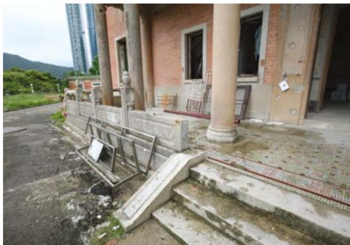
圖 21. 石護欄尋杖和抱鼓垂帶石被破壞
