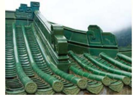
圖 105. 北坡面的垂脊壓坑（工人做法）
