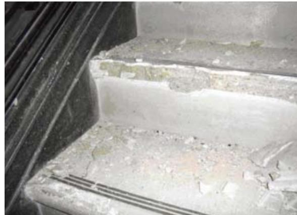
圖 29. 水磨石踏面和踢面全被破壞
