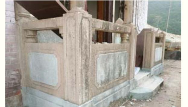
圖 24. 二樓北露台的出口平台護欄被嚴重破壞
