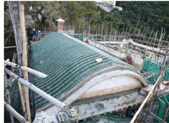
圖 59. 彎筒鋪砌重鋪前
