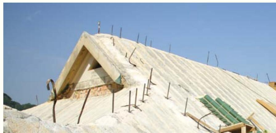
圖 53. 修補前（上圖）及修補中（下圖）的固定瓦脊鐵枝
