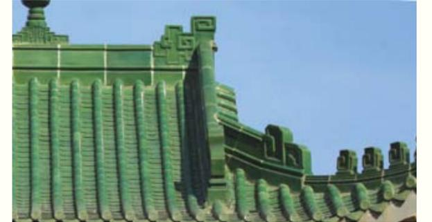
圖 104. 南坡面的垂脊壓筒（原狀做法）
