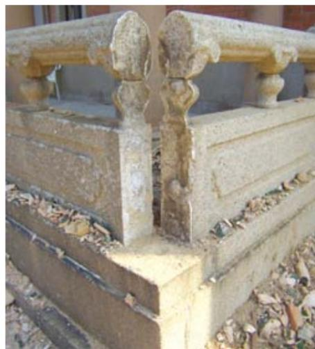
圖 22. 石護欄望柱被破壞
