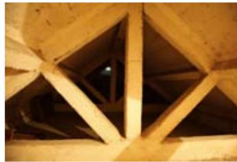
圖 137. 鋼筋混凝土屋頂和地台框架結構架空層
