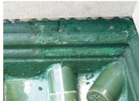
圖 61. 舊瓦件油漆被洗掉前
