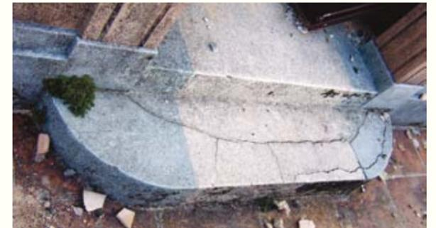
圖 17. 二樓外平台水磨石台階自然裂開
