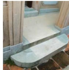
圖 91. 主樓二樓北露台的出口平台水磨石地面
