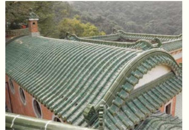
圖 60. 彎筒鋪砌重鋪後
