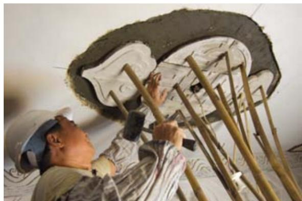
圖 70. 預製件灰塑的安裝
