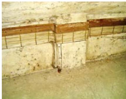
圖 150. 供電線路都有安全接地線
