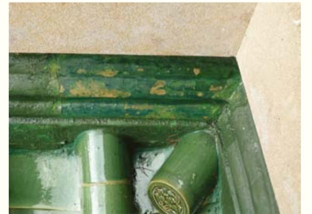
圖 62. 舊瓦件油漆被洗掉後
