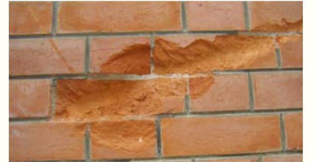
圖 7. 北立面紅磚牆被破壞
