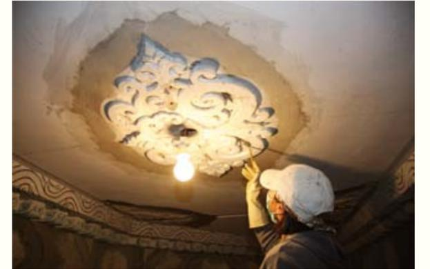
圖 130. 修補灰塑細部
