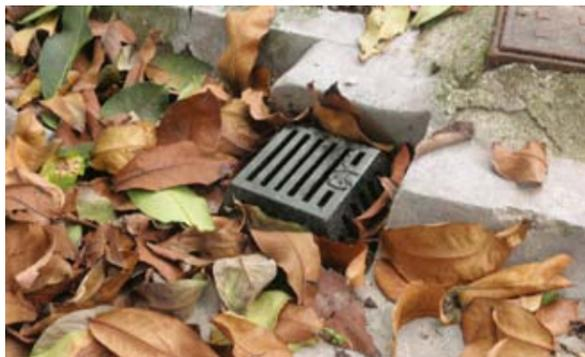
圖 92. 在去水口上面加高腳隔柵
