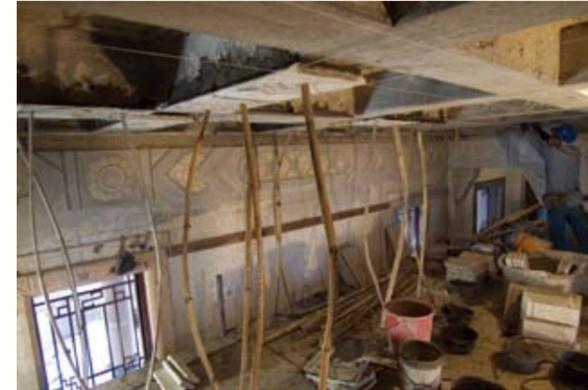
圖 129. 藻井樑底灰塑構件的臨時支撐
