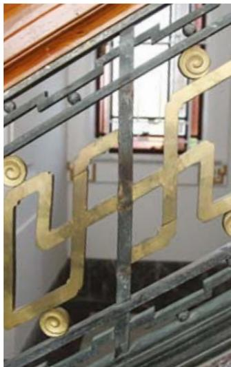
圖 129. 護欄上銅欄杆的螺接
