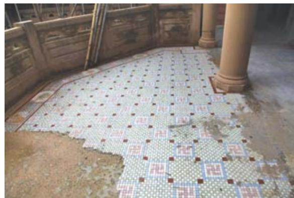
圖 15. 一樓露台馬賽克部分被破壞
