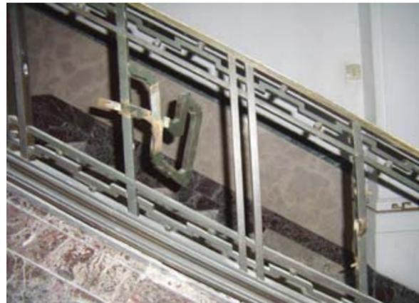
圖 27. 方銅護杆近半被拆除
