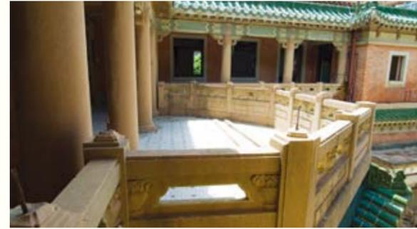
圖 23. 一樓向內院外廊護欄柱頭被破壞，僅存一個完好。
