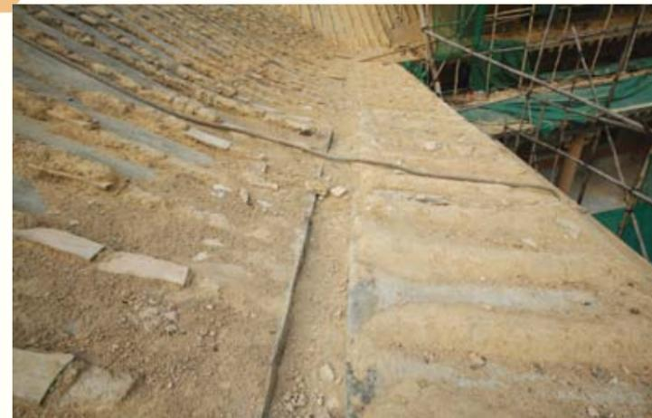
圖 37. 坡屋面截水溝被堵塞
