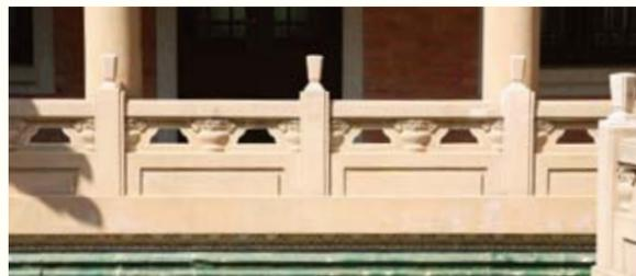
圖 42. 一樓露台水磨石護欄
