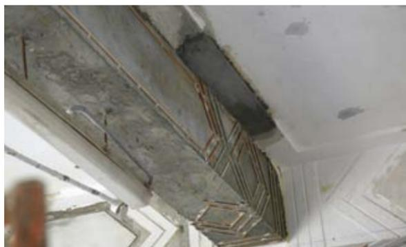
圖 95. 修補休息廊的混凝土樑柱
