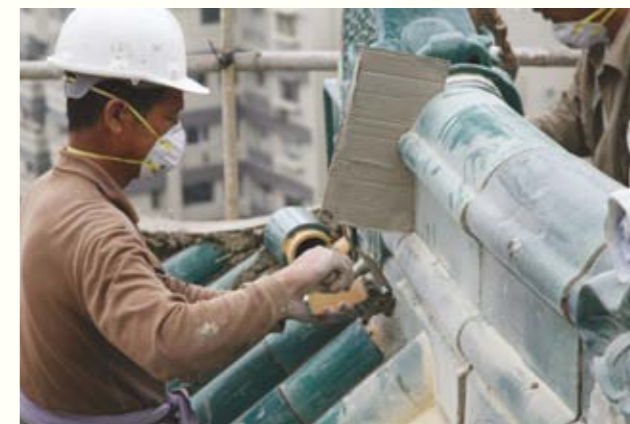
圖 74. 外門樓屋脊的復修
