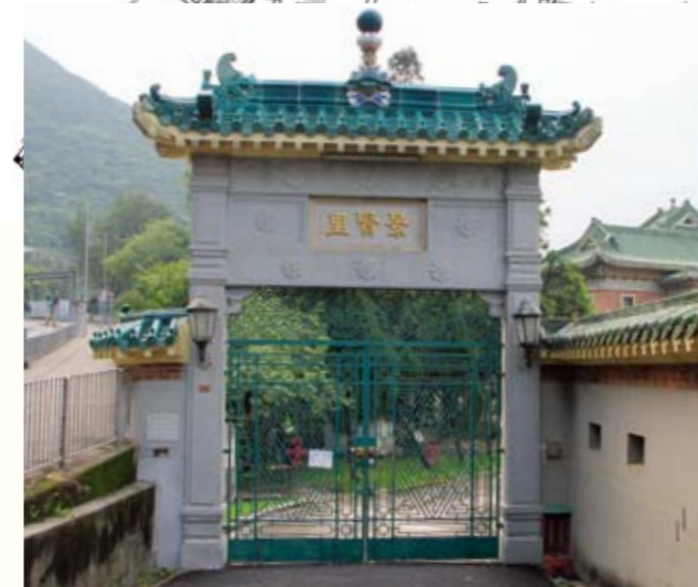
圖 51. 外門樓的平開鐵門
