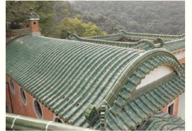
圖 60. 彎筒鋪砌重鋪後
