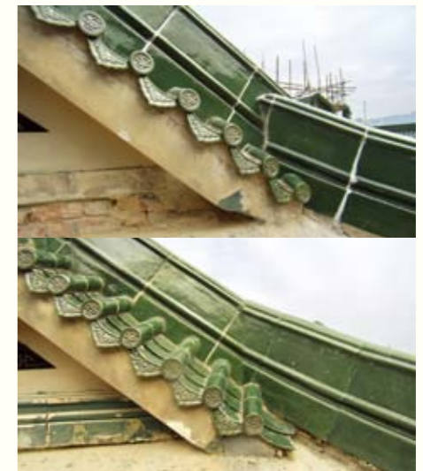
圖 119. 上圖為最初錯誤的連接，下圖為後來改正的連接
