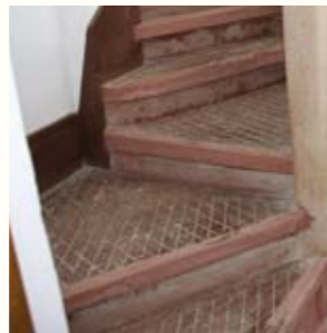
圖 79. 副樓（左圖）和車庫（右圖）的樓梯的梯級踏面有菱形防滑槽
