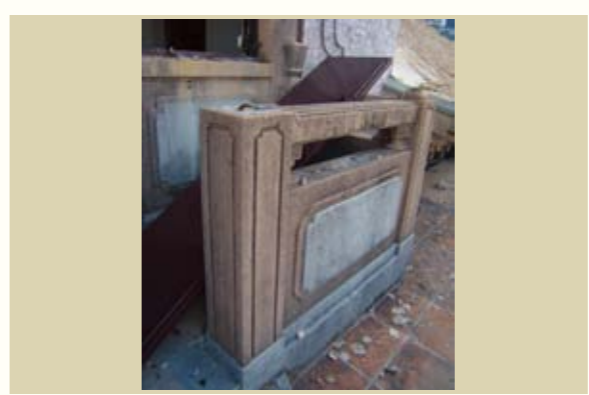
主樓二樓北露台護欄
