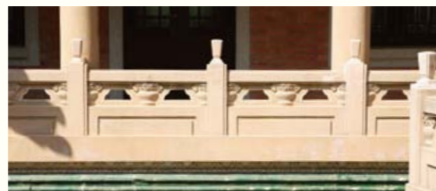
圖 42. 一樓露台水磨石護欄
