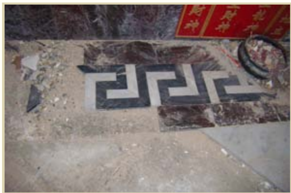
主樓地下正廳地面
