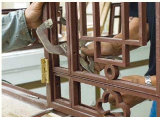
圖 84. 鐵窗成品運到現場後經調校合格後才安裝
