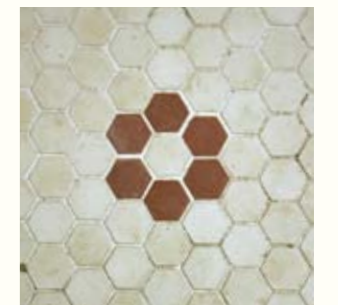
圖 85. 地下西間浴廁地面
