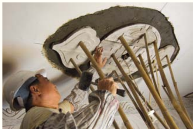
圖 70. 預製件灰塑的安裝
