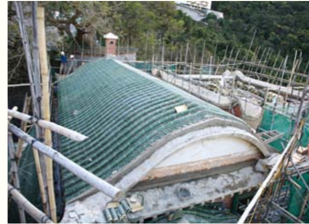
圖 59. 彎筒鋪砌重鋪前
