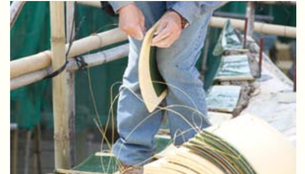
圖 116. 工人正在給瓦片穿銅線
