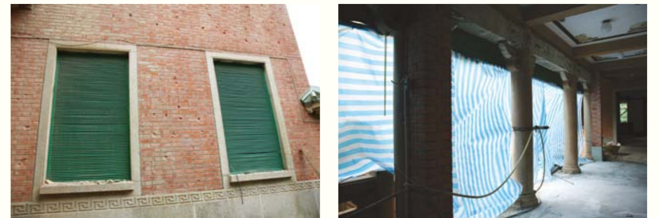
圖 45. 窗戶臨時安裝防雨通風百葉（左），一樓外廊安裝防水布（右）
