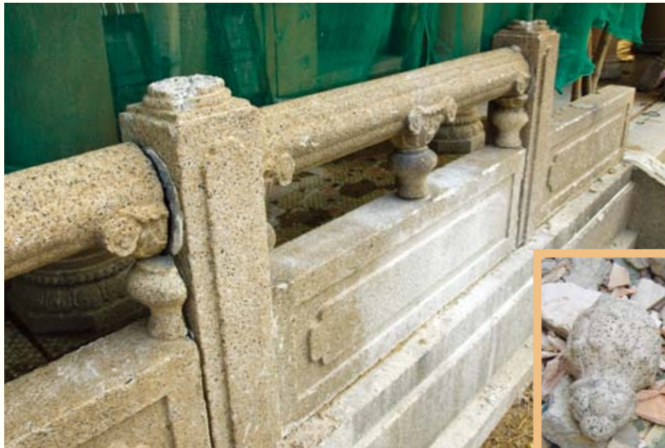
圖 20. 石護欄被破壞的柱頭
