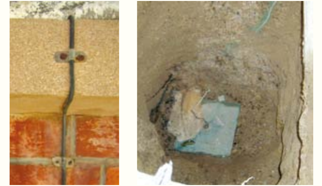
圖 151. 景賢里主樓的原防雷引下線
