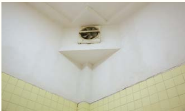
圖 147. 廚房的排煙管道
