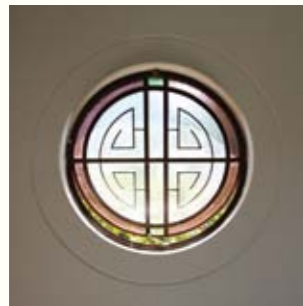
圖 67. 副樓一樓的外牆窗
