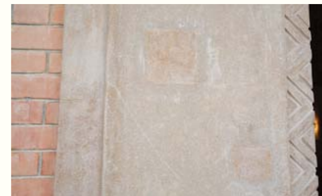
圖 124. 圖中的兩塊「補丁」是大門門套新補的水磨石
