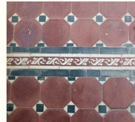
圖 98. 車庫一樓的水泥花階磚地面
