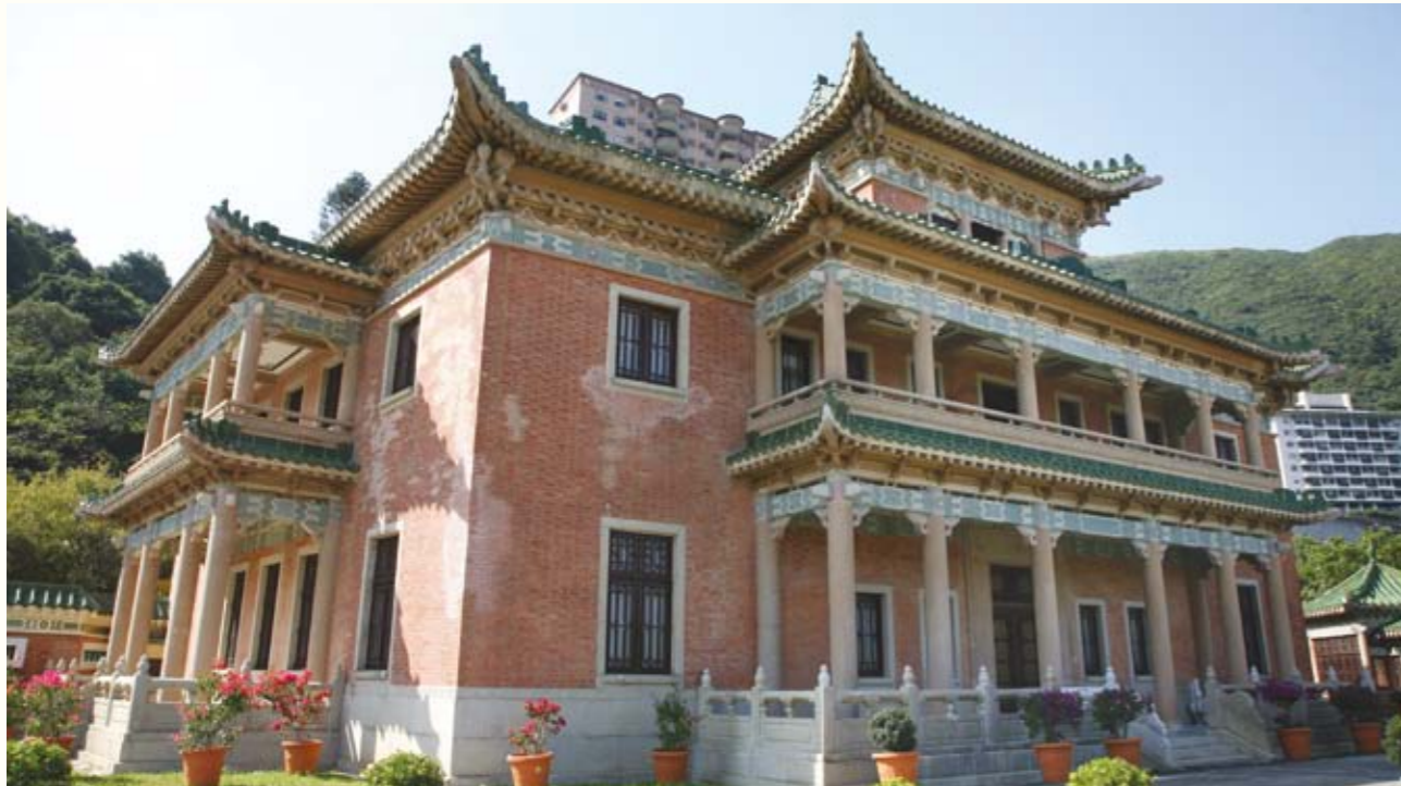
圖 48. 景賢里的台基
