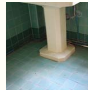
圖 84. 地下東間浴廁地面
