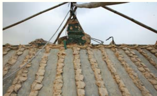
圖 115. 架空鋪瓦的沙漿排列原狀
