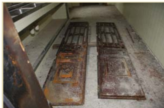
主樓與副樓地下過道的鐵門
