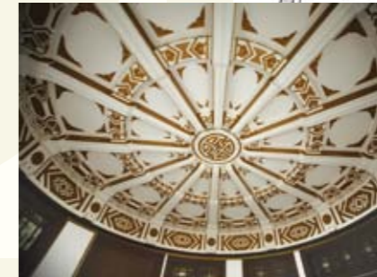
圖 108. 主樓地下中餐廳天花的金漆灰塑
