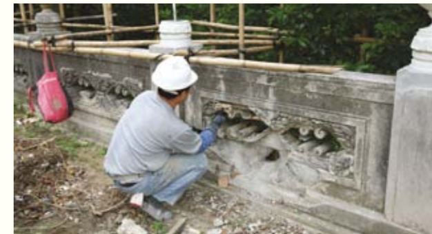
圖 88. 修補護欄的灰塑花飾
