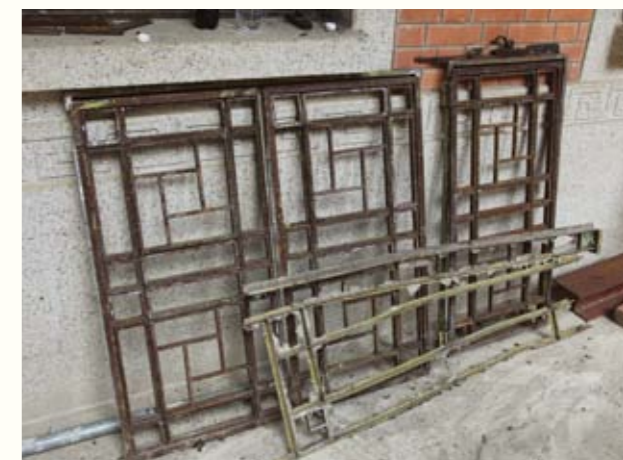
圖 47. 要求用鉚接工藝修理的鐵花格窗
