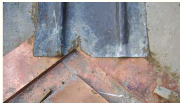
圖 58. 斜溝與截水溝的交接處
