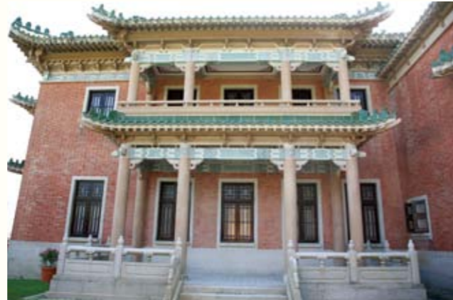
圖 15. 主樓西立面不開門
