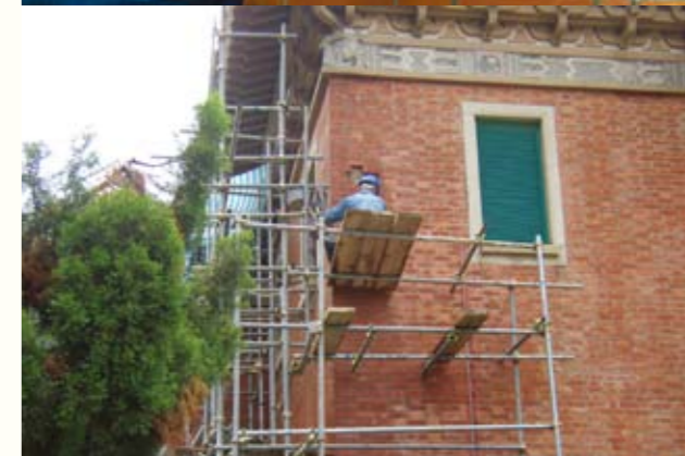
圖 72. 紅磚牆的修補
