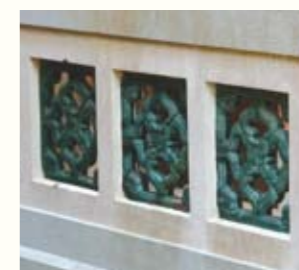
圖 46. 副樓一樓外廊護欄
