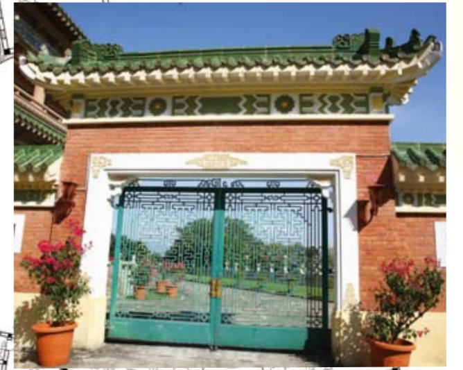
圖 52. 內門樓的平開鐵門
