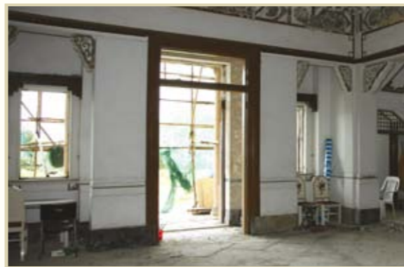
主樓地下入口木門
