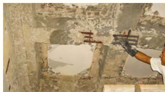
圖 121. 先把損壞的基層復修
