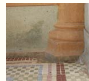
圖 44. 柱礎、踢腳線和平座的連接
