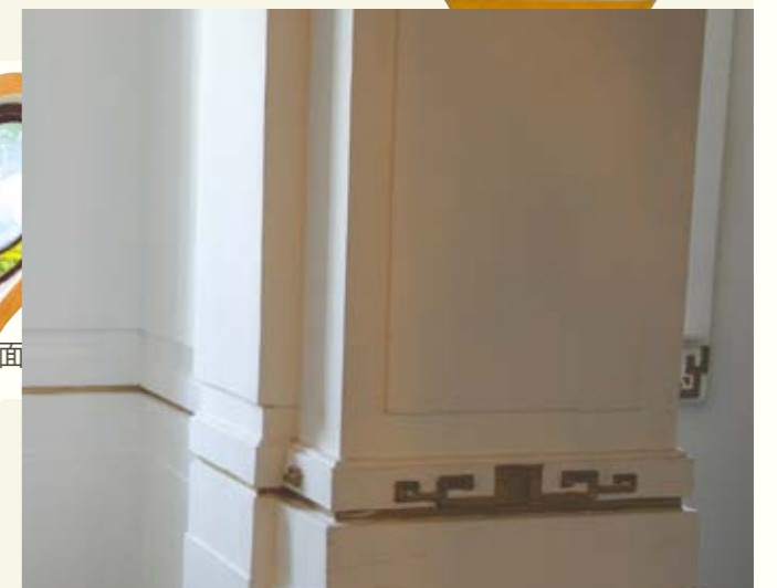
圖 111. 主樓地下正廳的壁柱塑有金漆夔紋腰線
