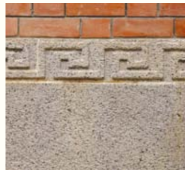
圖 101. 外牆牆裙的石雕
