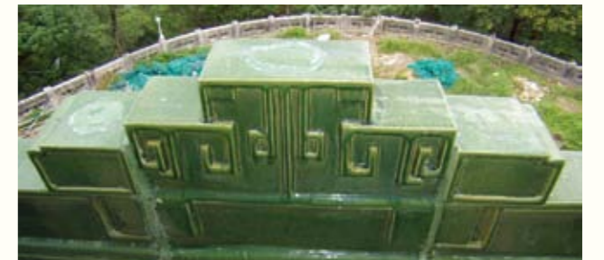
圖 111. 最初博古頂有開放氣孔
