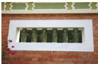
圖 118. 內圍牆漏窗的琉璃竹節筒
