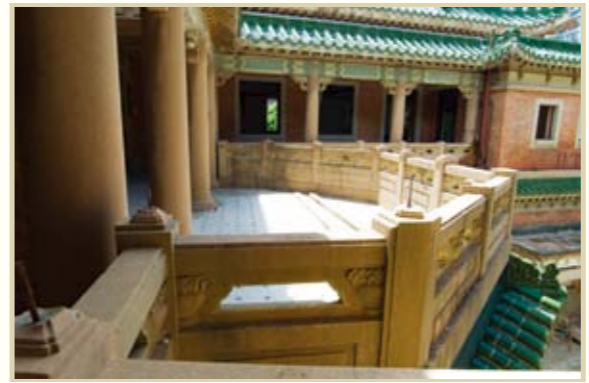
主樓一樓南露台護欄
