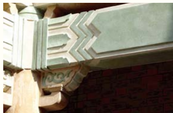
圖 120. 雀替斗拱和樑枋上箍頭的三件凸起如意頭是預製件
