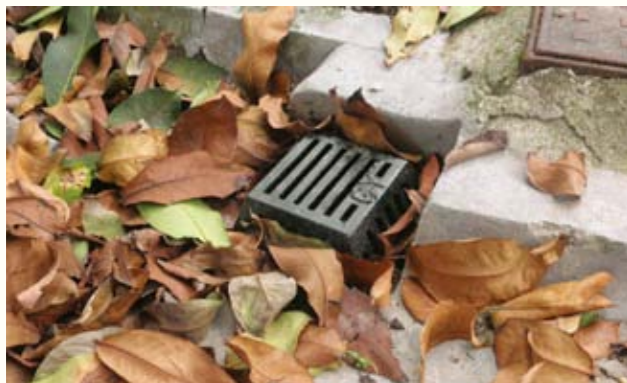
圖 92. 在去水口上面加高腳隔柵
