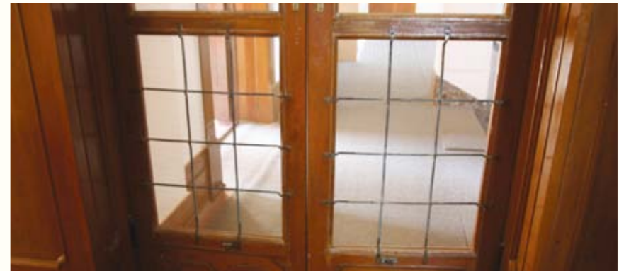
圖 65. 主樓一樓正廳通向兩翼廳房的木框銅紗門
