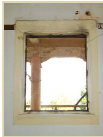
主樓一樓東立面外廊的三重窗
