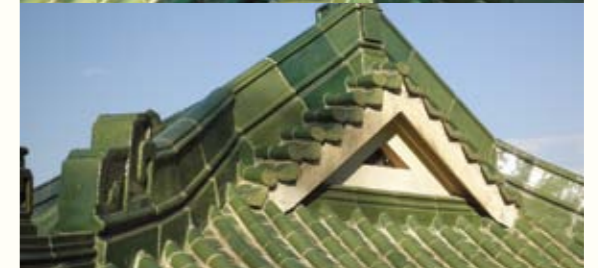
圖 118. 斜脊與垂脊相接（上圖為內側，下圖為外側）
