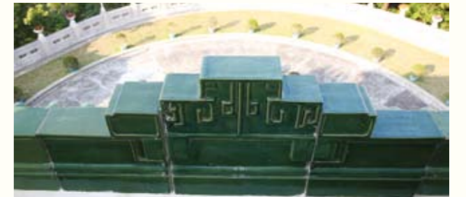
圖 112. 改進後博古頂取消放氣孔
