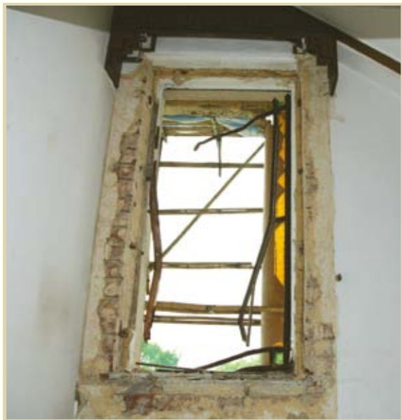
主樓地下北立面外廊的二重窗
