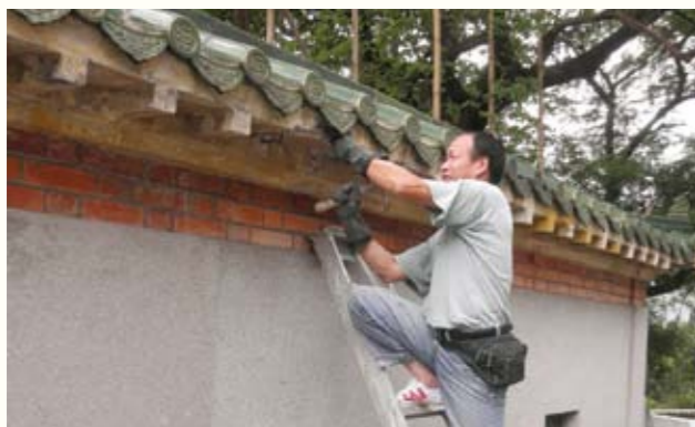
圖 94. 外圍牆的復修
