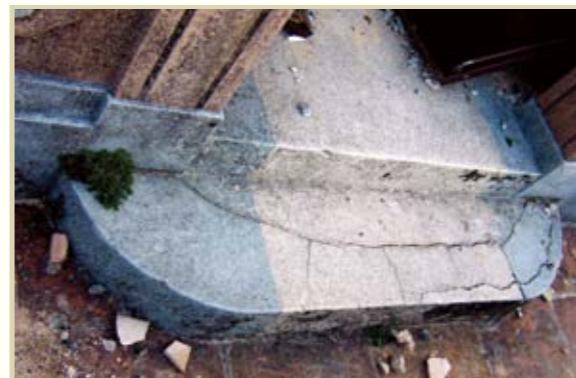
主樓二樓北露台地面
