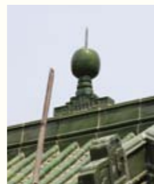
圖 102. 原避雷系統繼續使用
