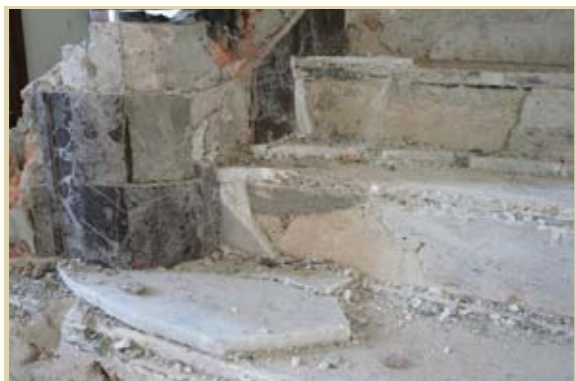
主樓與副樓之間的樓梯級
