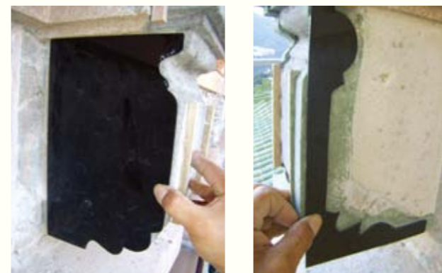
圖 123. 用卡模法控制樑頭造型的準確性（圖中黑色是卡模）
