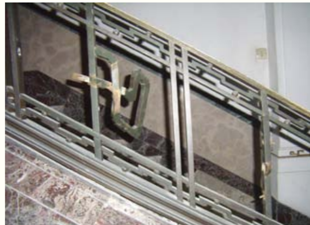
圖 27. 方銅護杆近半被拆除
