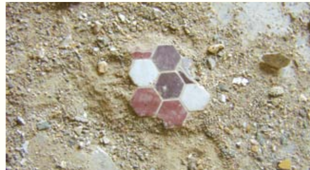
圖 16. 二樓正廳和後庫地面馬賽克全部剷掉
