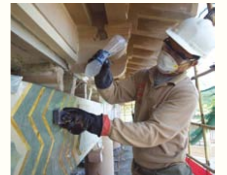
圖 68. 現場復修水磨石額枋
