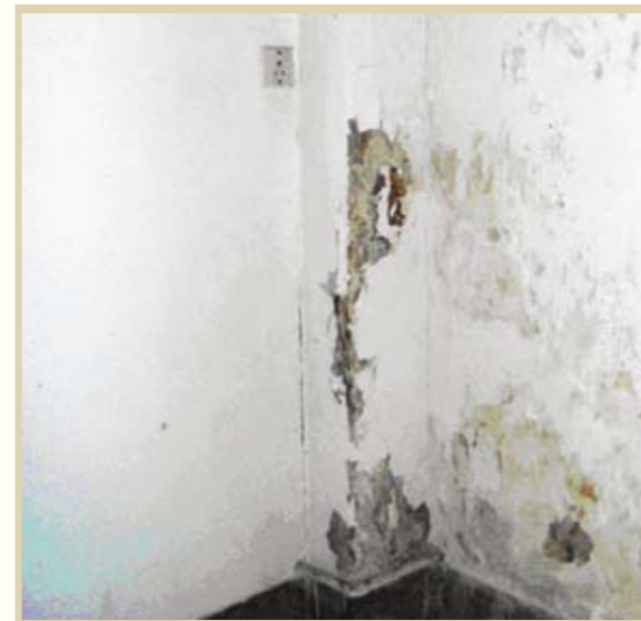
主樓二樓西北角 (內藏落水管)
