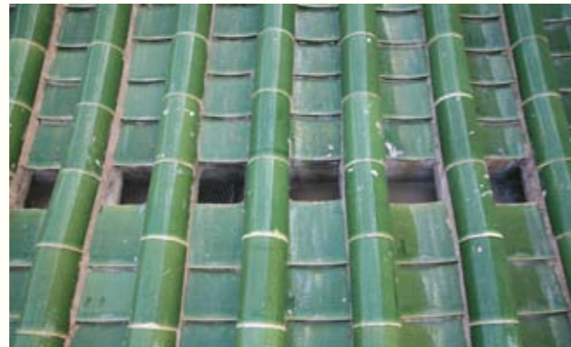
圖 56. 復修好的坡屋面截水溝
