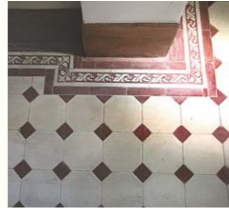
圖 95. 副樓地下和一樓的過道、房間、外廊全部鋪水泥花階磚
