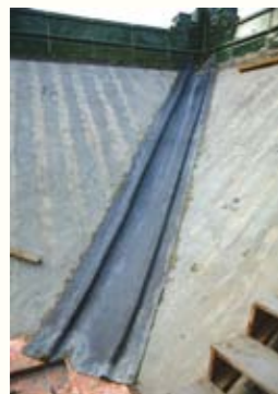
圖 57. 附加的鉛皮斜水溝
