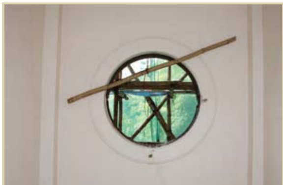
副樓一樓的一重窗
