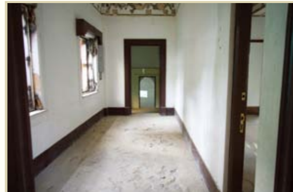
主樓與副樓一樓過道地面
