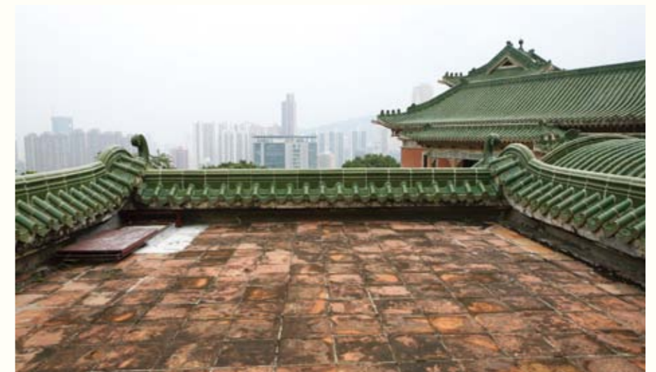
圖 99. 主樓天台（二樓北露台）地面（左圖）和車庫天台地面（右圖）鋪廣東大階磚
