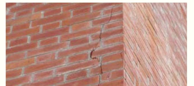
圖 10. 牆體轉角有垂直裂縫
