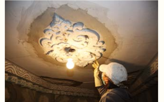
圖 130. 修補灰塑細部
