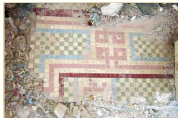
主樓外廊馬賽克地面
