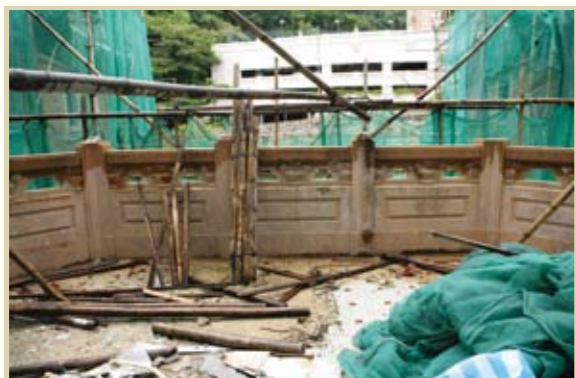
主樓一樓露台地面
