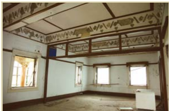
主樓一樓東翼的摺疊門
