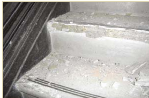
主樓一樓與二樓之間的樓梯級
