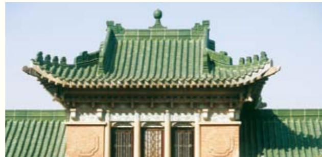
圖 113. 主樓二樓屋面瓦坑為陰數
