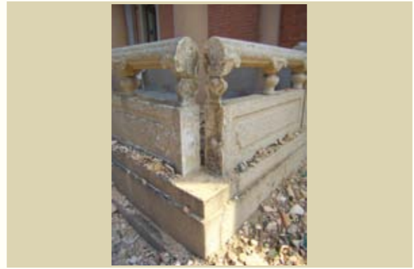
主樓地下外廊護欄望柱
