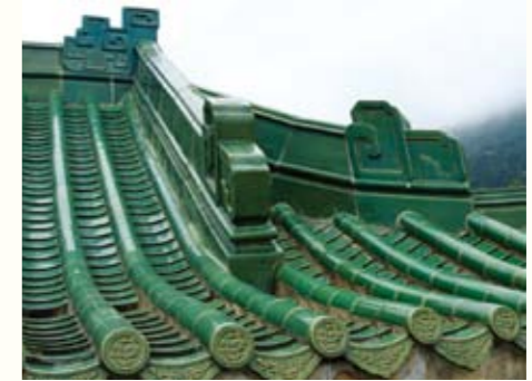
圖 105. 北坡面的垂脊壓坑（工人做法）
