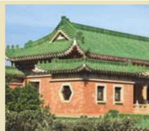
圖 31. 主樓東西兩翼屋頂南端的歇山頂和浴廁的盪頂
