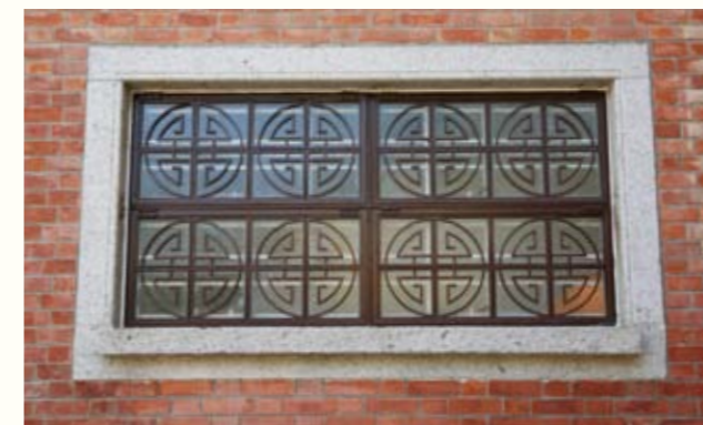
圖 74. 主、副樓過道的排窗
