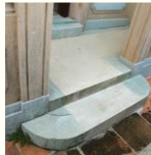
圖 91. 主樓二樓北露台的出口平台水磨石地面
