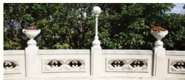
圖 45. 山地斜坡護欄
