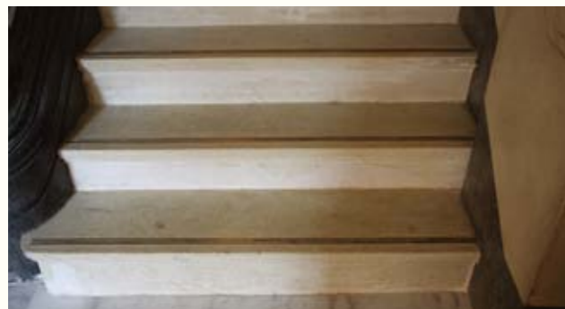
圖 78. 主樓一樓上二樓梯級踏面鑲嵌青銅防滑條
