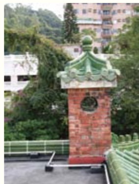
圖 148. 廚房屋頂的排氣煙囪
