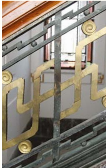
圖 129. 護欄上銅欄杆的螺接
