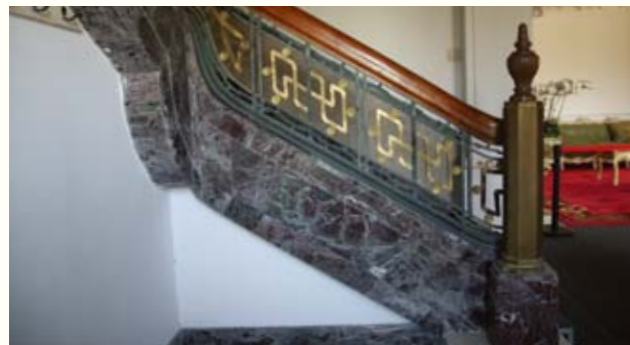
圖 77. 主樓樓梯精緻的銅製欄杆
