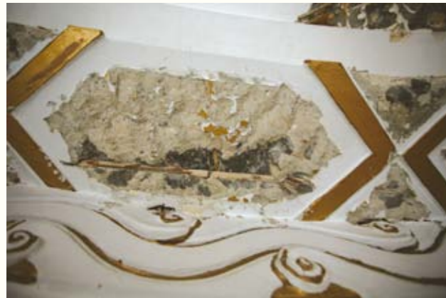
圖 65. 殘件中發現預埋竹筋的工藝
