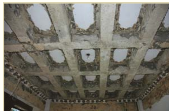
主樓二樓天花灰塑
