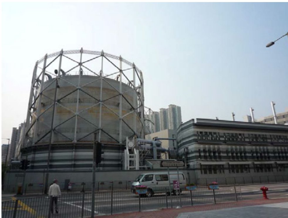
Fig. 74. Ma Tau Kok Gas Plant, 2009.
