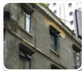
外牆。 External walls.
