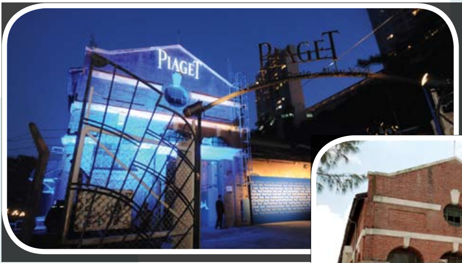
變身後的大潭篤抽水站 The "transformated" Tai Tam Tuk Pumping Station
