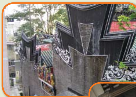
魯班先師廟天面 Roof, Lo Pan Temple
