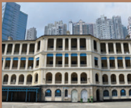
營房大樓 Barrack Block
