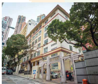
東華醫院主樓 Main Block, Tung Wah Hospital
