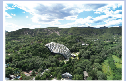
中國北京周口店北京人遺址第一地點（猿人洞） 保護建築 Protective Shelter at the Locality 1 Archaeological Site of Zhoukoudian Peking Man Cave World Heritage Site, Beijing, China
