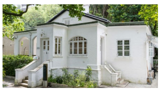
西環濾水廠 West Point Filters
