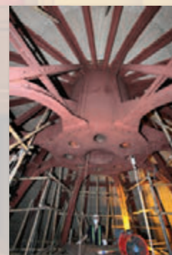
前立法會大樓拱頂之內部
