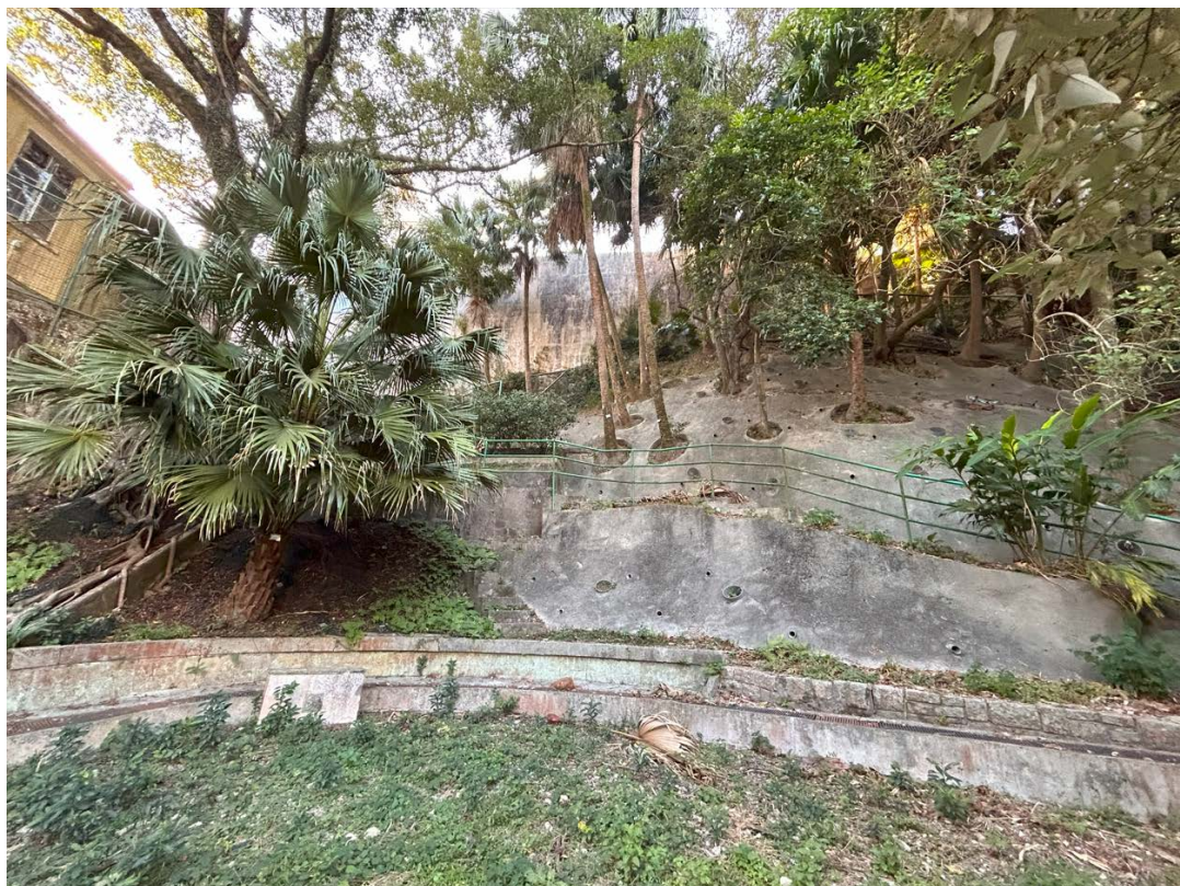
1.5 斜坡的整体景观
