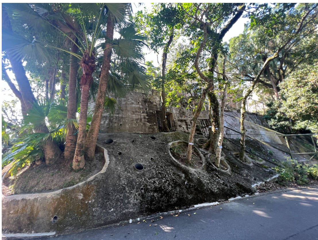
1.6 斜坡的整体景观
