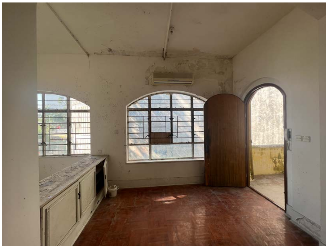
2.4 入口大厅的整体景观
