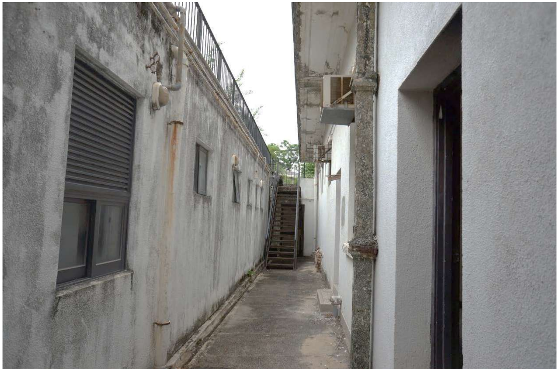
位于主楼与扩建部分中间的天井
