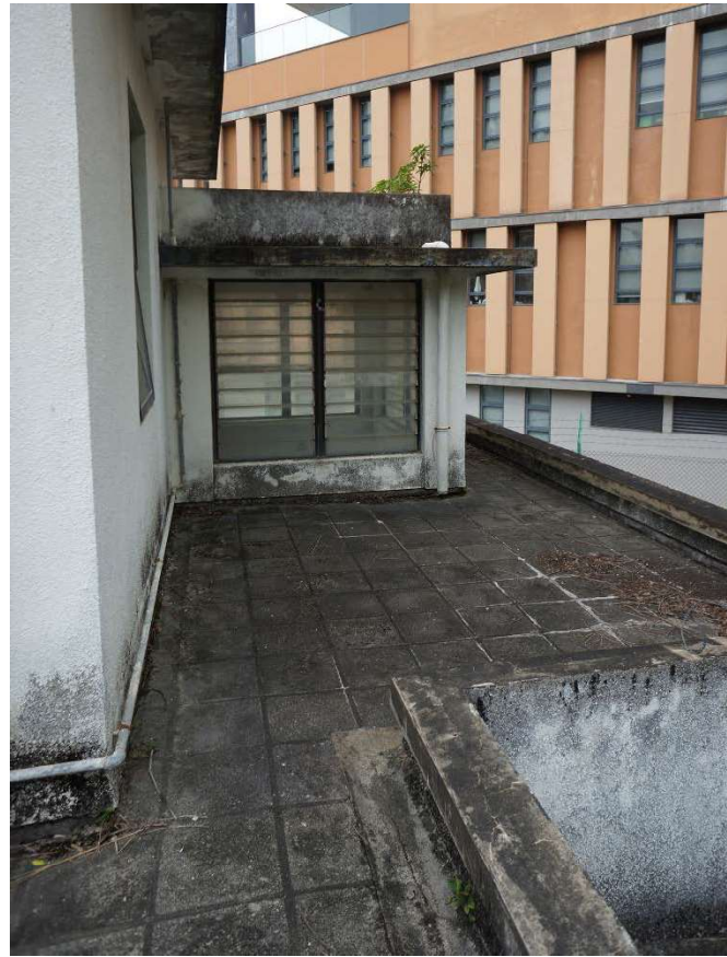
扩建部分天台视图
