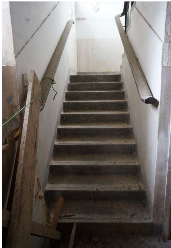
扩建部分由地下至一楼的楼梯（地下）(G/F)
