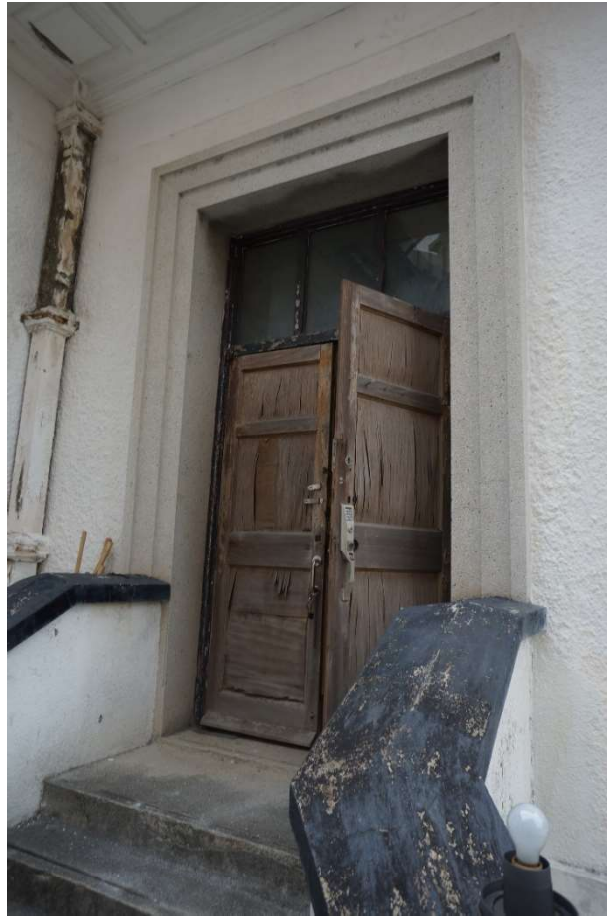
主楼北面入口（地下）(G/F)
