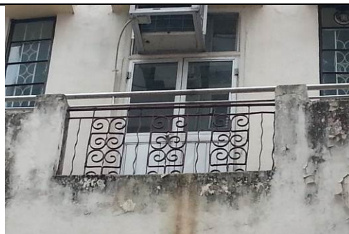
1.7) 二樓的鐵製裝飾欄杆 (不銹鋼欄杆並非原有設計)
