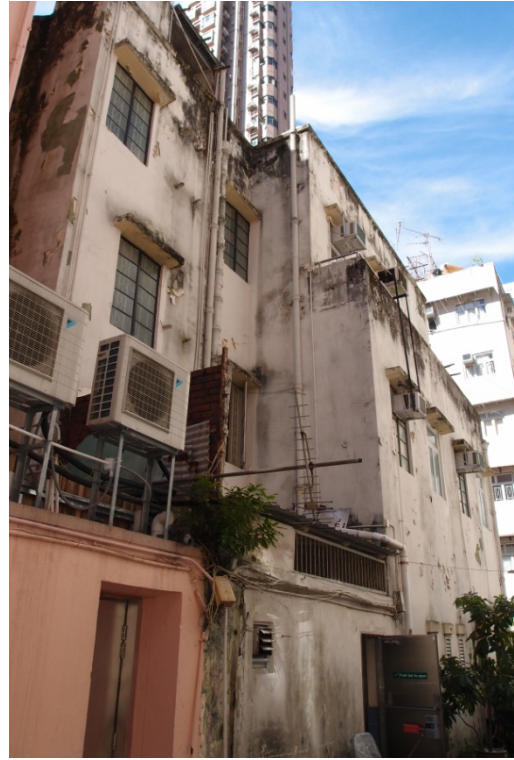
1.5 東南立面（面向第一巷）
