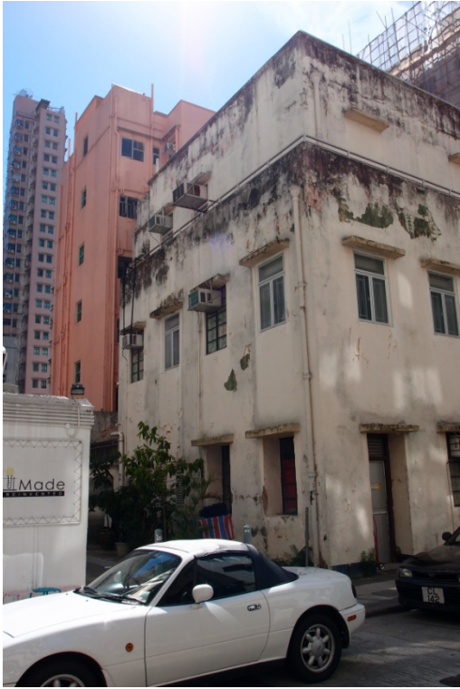
1.4 東南立面（面向第一巷）
