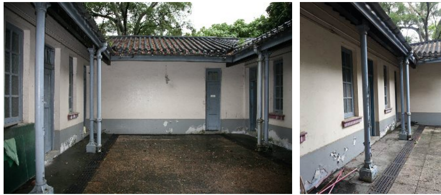
2.8) 在平房天井內支撐屋簷的鑄鐵支柱，包括混凝土柱腳
