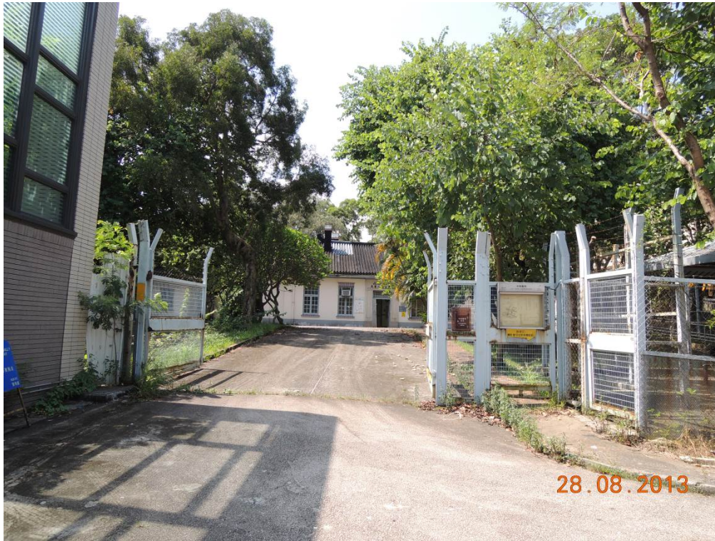
1.1 入口大閘（古洞南路）
