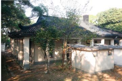
1.17) 柱廊式外廊，包括混凝土方形柱和鋪面的花崗岩邊緣石
