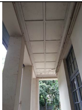
1.18) 沿柱廊式外廊建造的木製假天花
