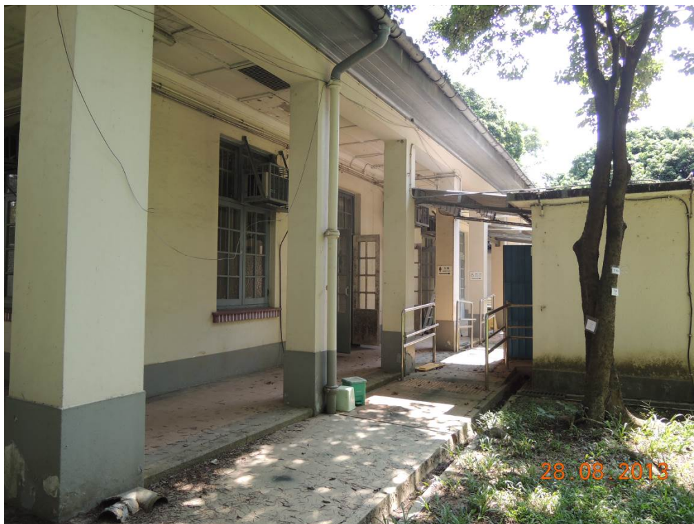
2.3 主樓後視圖（向古洞路）
