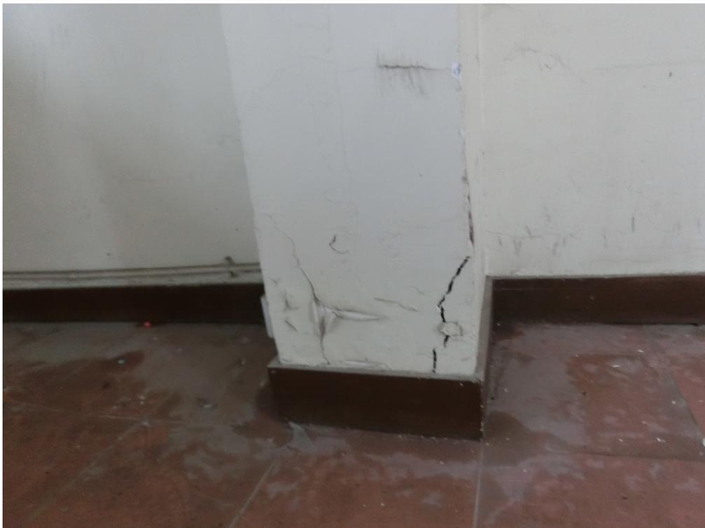
地下報案室內的柱有混凝土剝落及裂痕的實例
