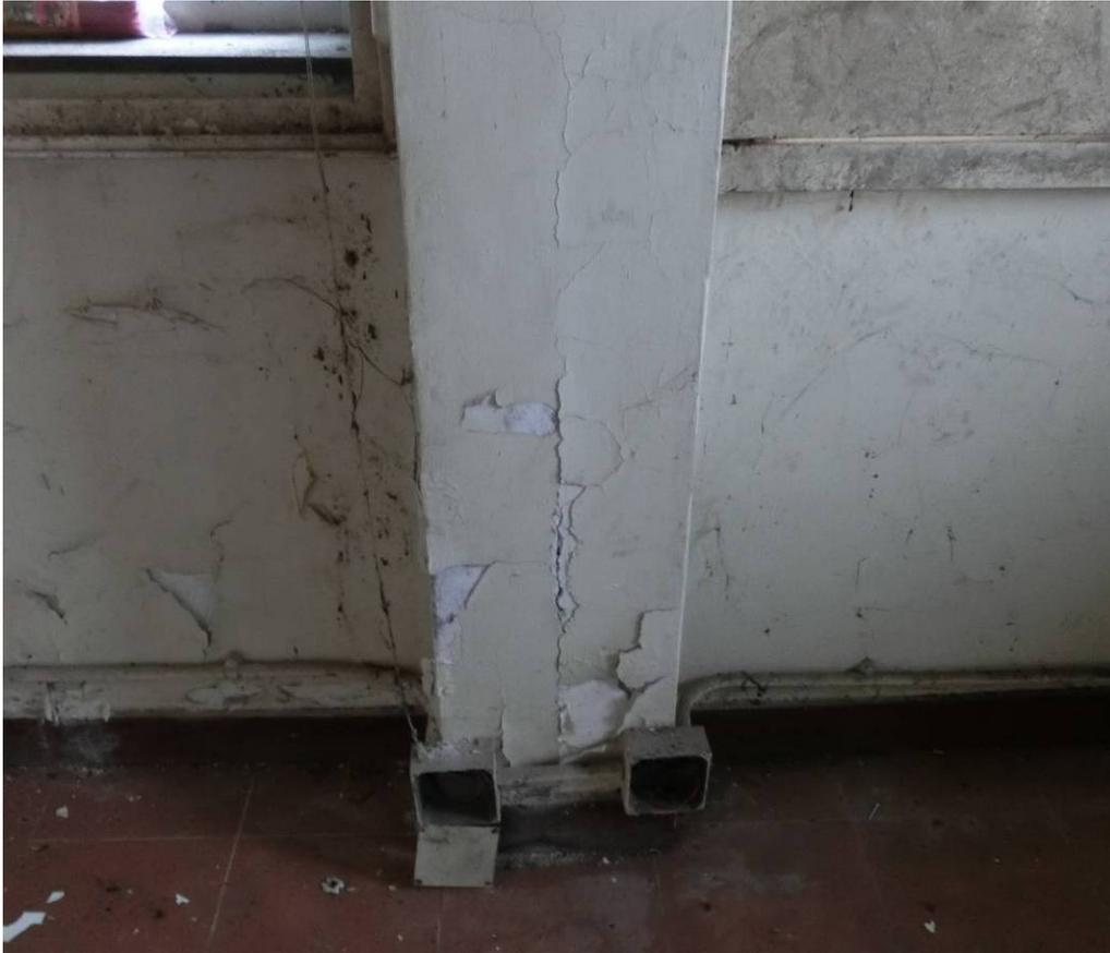
地下報案室內的柱有混凝土剝落及裂痕的實例
