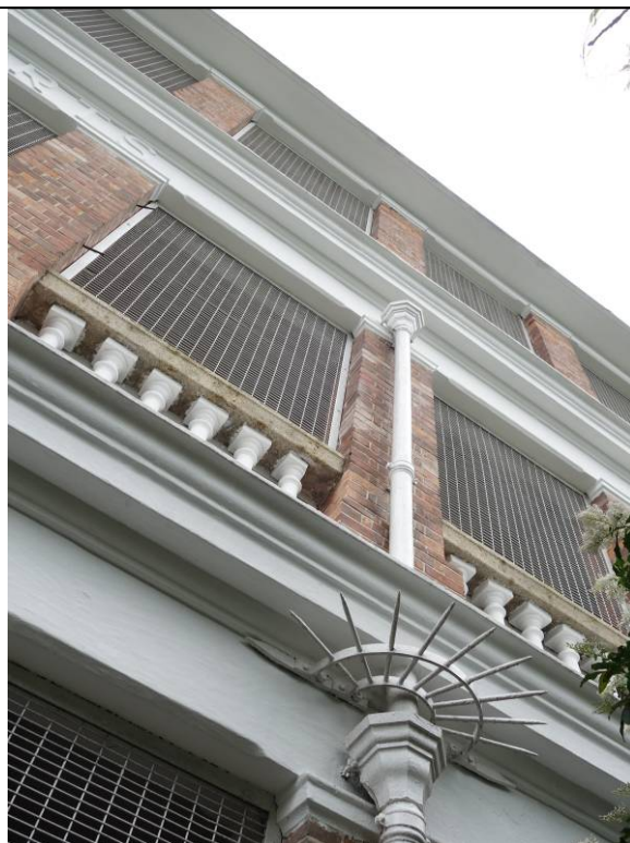
主樓的正立面
