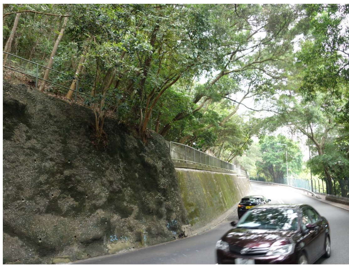
面向堅尼地道的擋土牆的視圖
