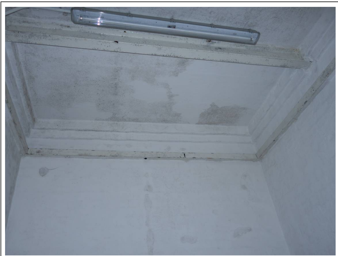
一樓廚房天花
