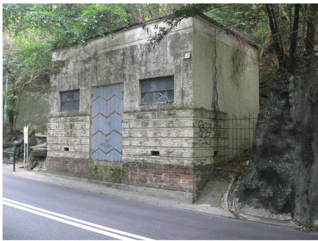
面向堅尼地道的變電站的視圖
