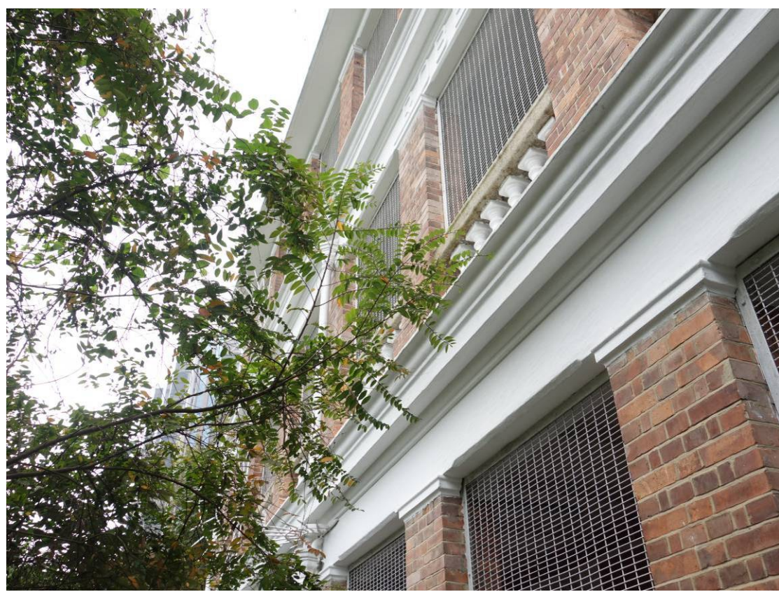
主樓的正立面
