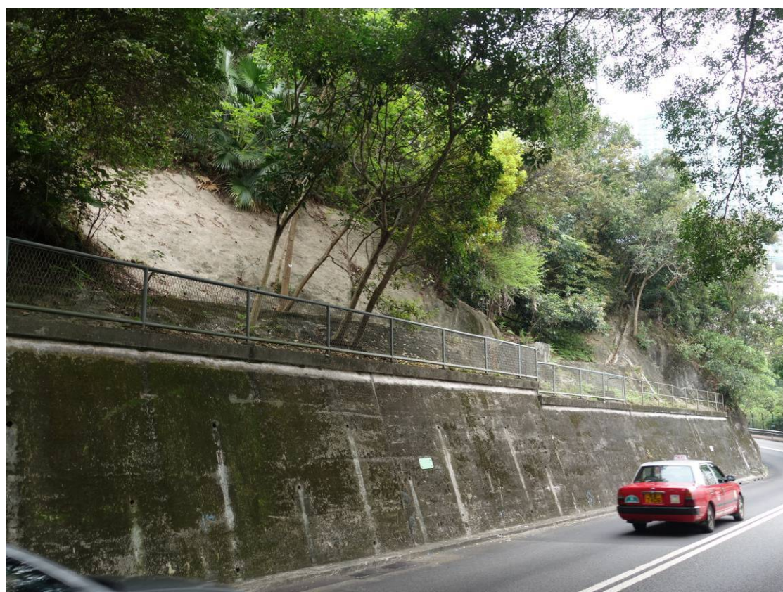
面向堅尼地道的斜坡的視圖
