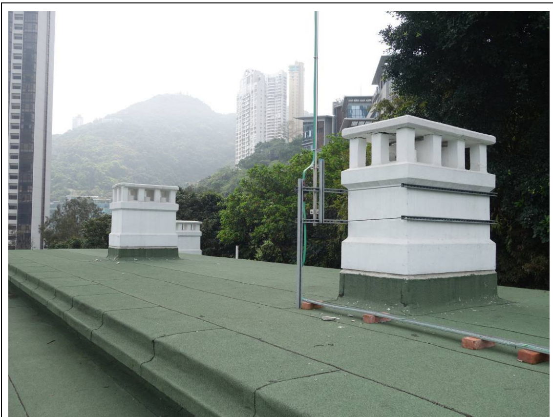
羅拔時樓屋頂的視圖
