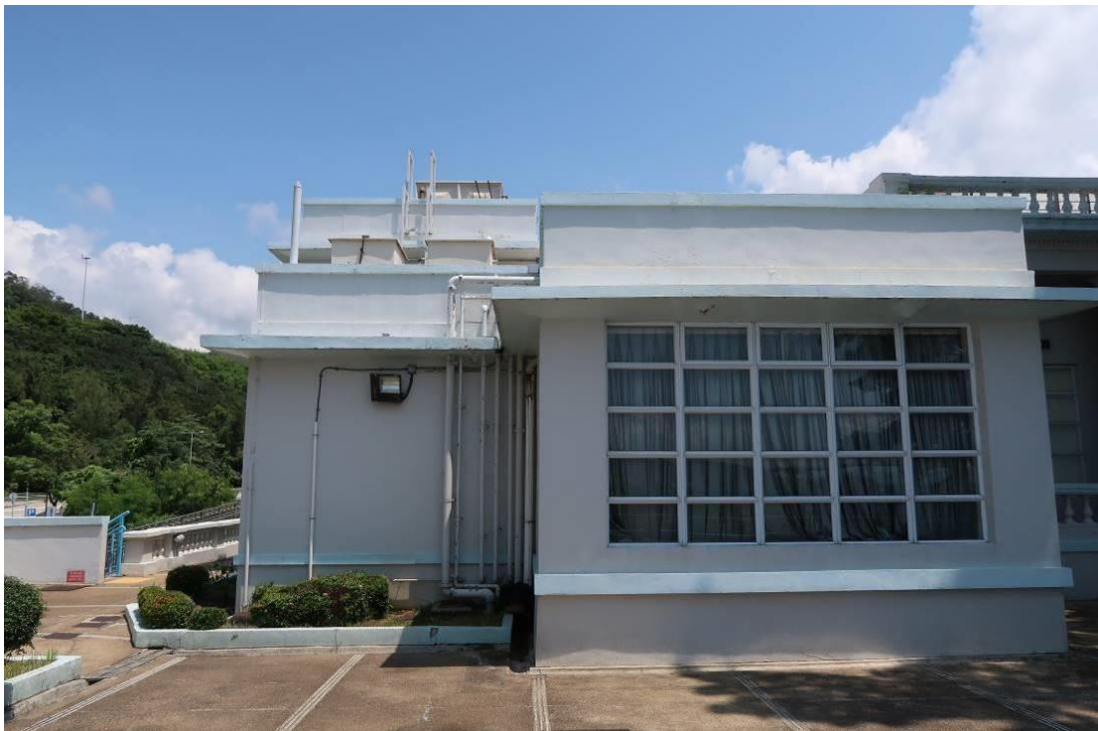
擴建部分 (西南面)
