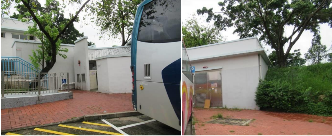
附屬建築 (垃圾收集站及電力變電站)
