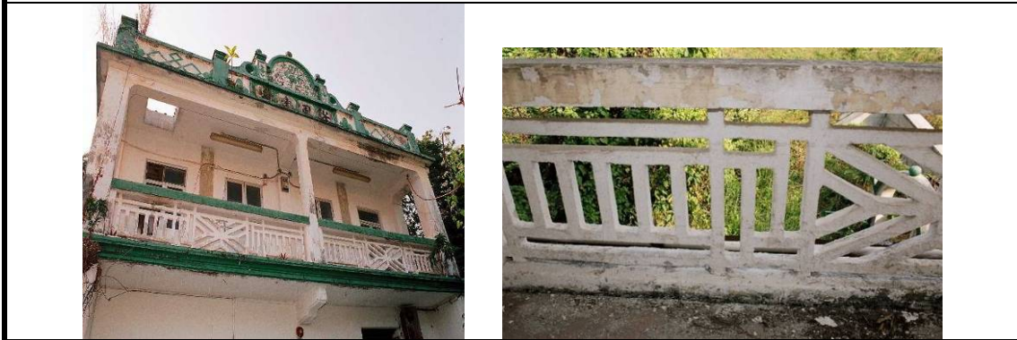
2.6) 正面外牆一樓的開敞式露台，包括支柱、幾何設計的欄杆、地板下的模壓斗拱
