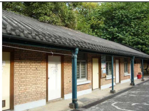
6.2)中式金字瓦頂和附有鐵柱的長廊
