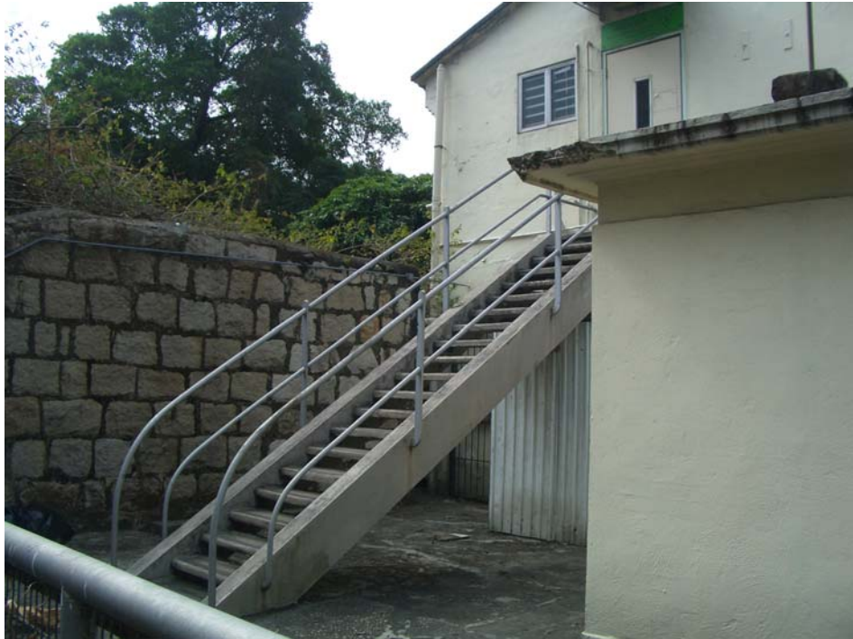
中區一幢大樓前的樓外樓梯
