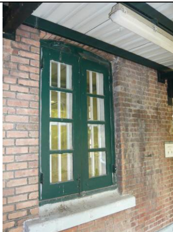
5.5) 附有防盜柵欄的木豎鉸鏈窗，以及窗口的水泥抹面磚砌窗台
