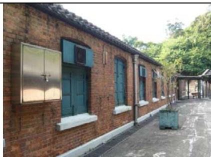
5.1)連拱窗和門口的紅磚牆，以及用以支撐屋頂桁架的水泥基座和墩
