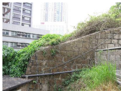
1.1) 面向青山道和位於上區的粗石擋土牆，以及該址內的支撐斜坡
