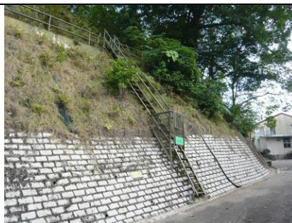
1.1) 面向青山道和位於上區的粗石擋土牆，以及該址內的支撐斜坡
