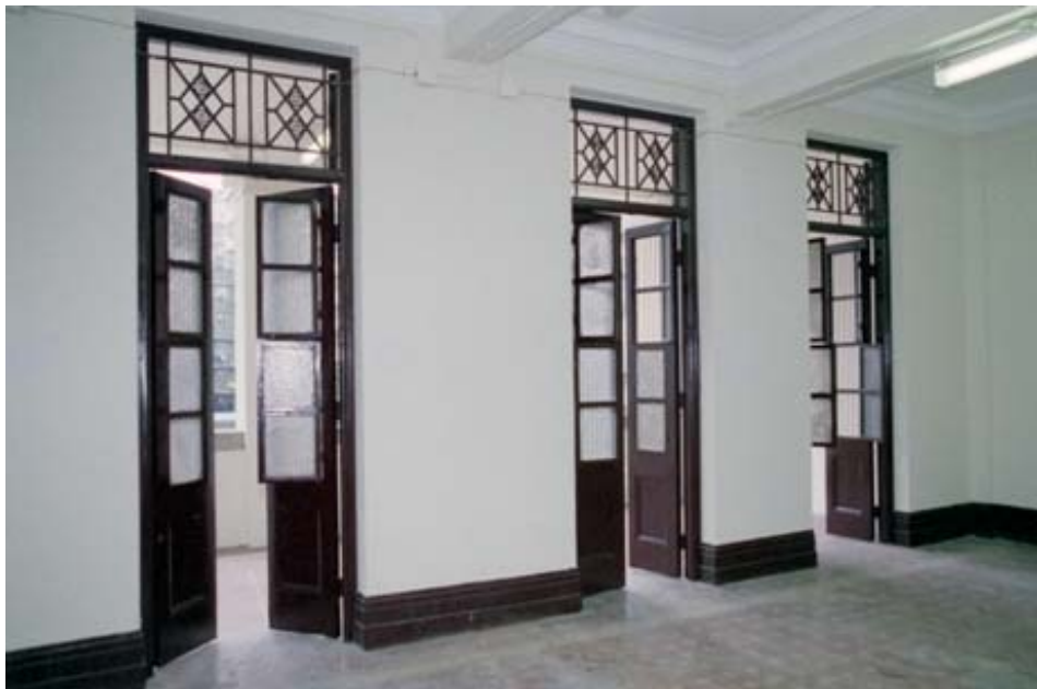
房間與外廊之間的木門
