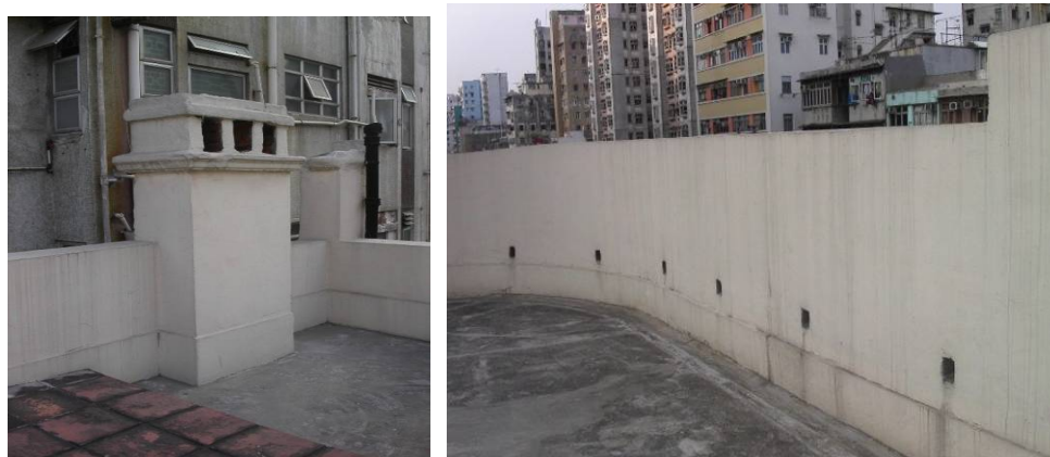
1.11) 磚建煙囪槽、水箱、矮牆連排水口
