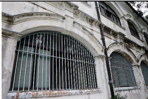
2.3) 生鐵雨水落管和雨水斗
