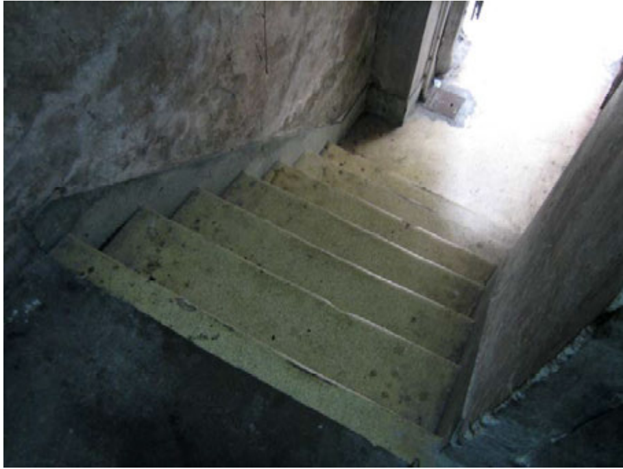
建築物內鋼筋混凝土樓梯
