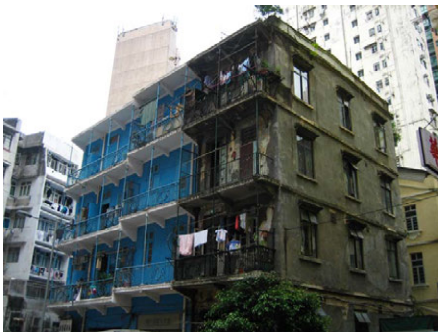
石水渠街72至74A號正面及側面
