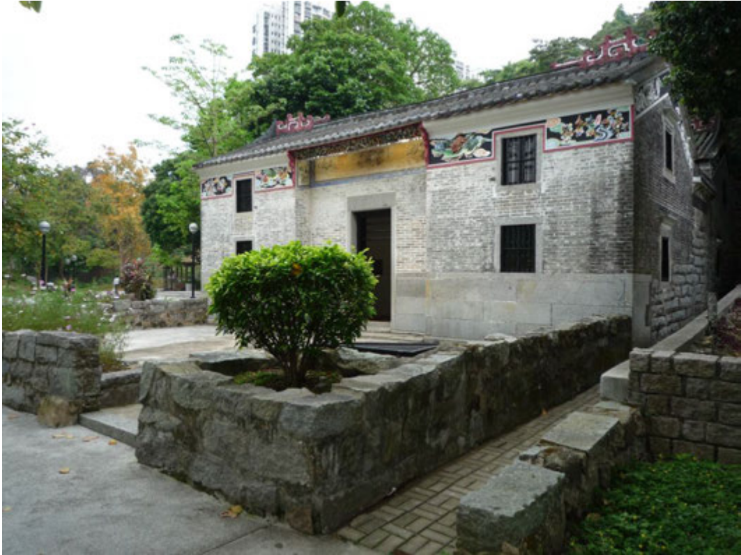
古屋正面及前面空地
