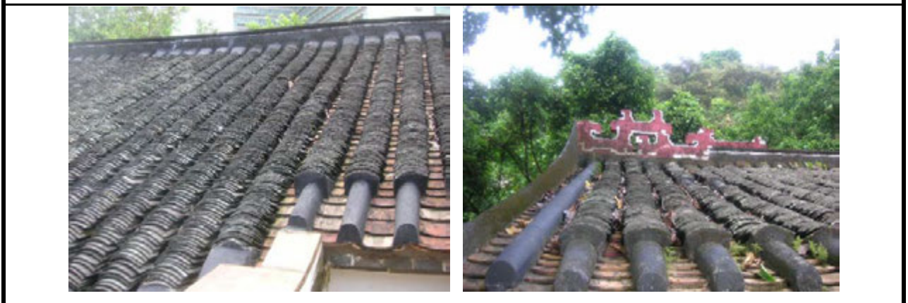
1.6) 中式瓦片屋頂連前後屋脊末端的「博古」圖案
