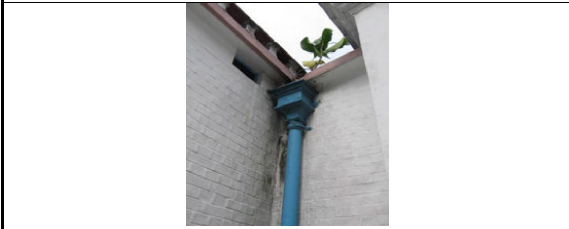
1.10) 設於後翼羈留所外的鑄鐵排水渠和雨水斗
