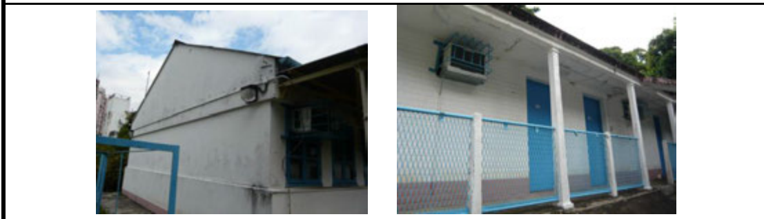
2.2) 已上漆的磚砌外牆
