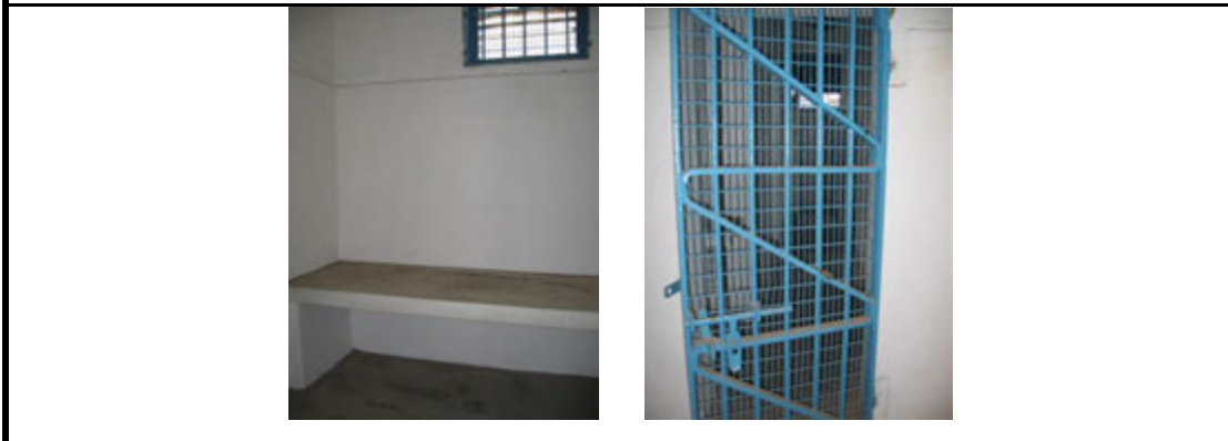
1.4) 羈留所，連兩間羈留室、保安門、廁所和走廊
