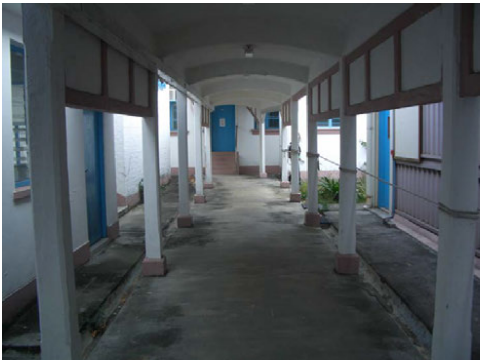
主樓內院的走廊
