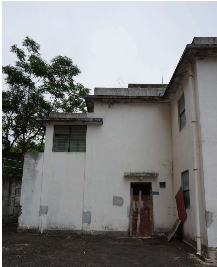
擴建部分的西立面
