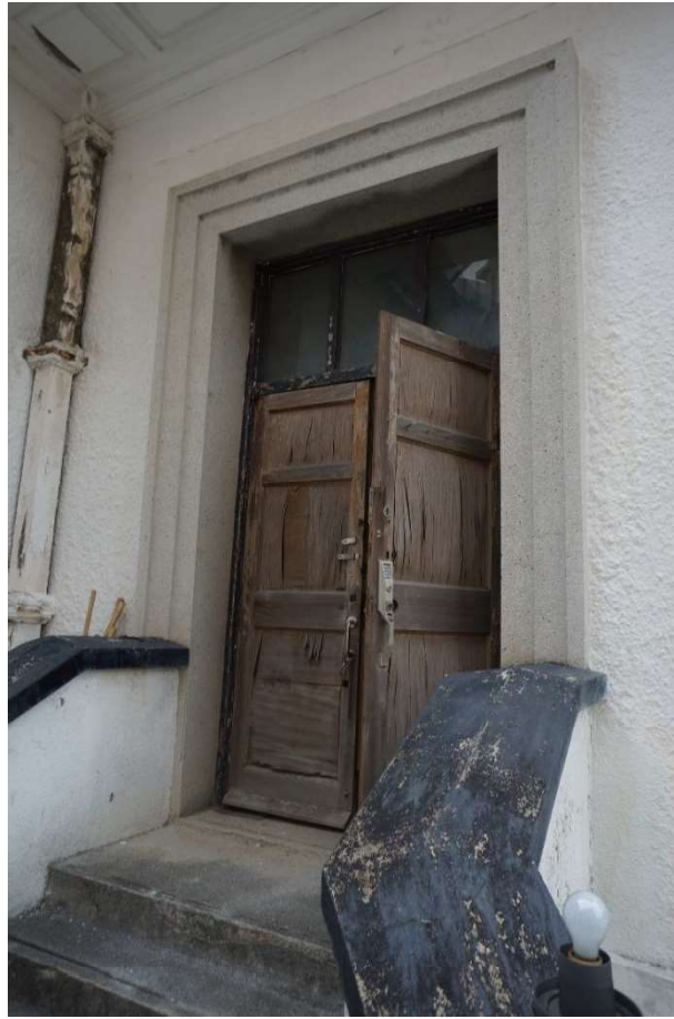
主樓北面入口（地下）(G/F)
