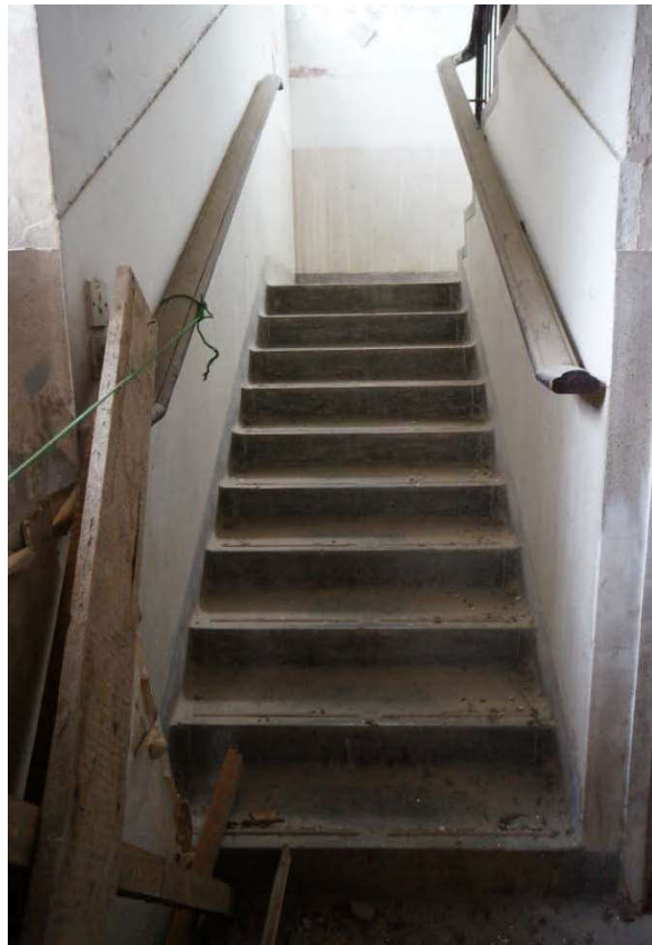
擴建部分由地下至一樓的樓梯（地下）(G/F)
