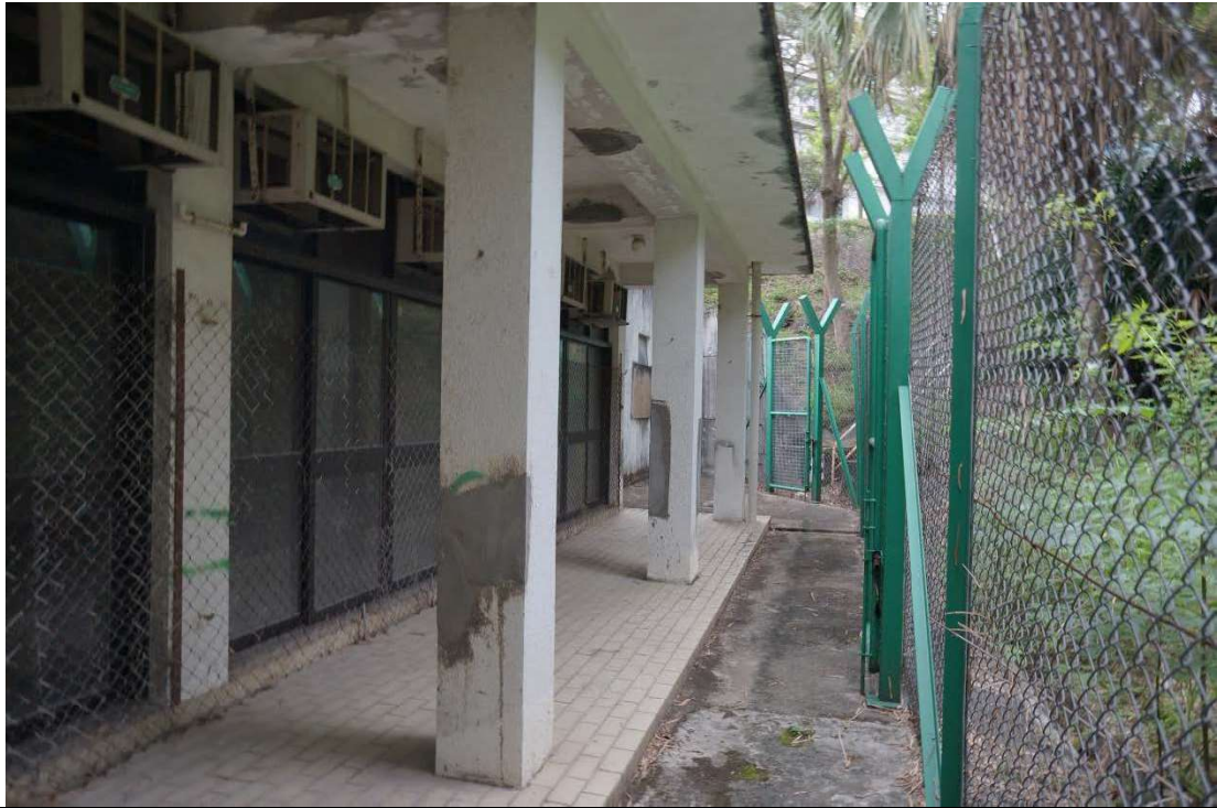
擴建部分的東立面
