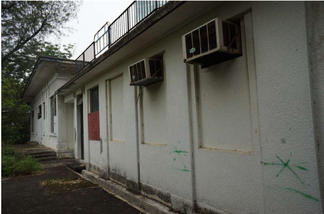
擴建部分的南立面
