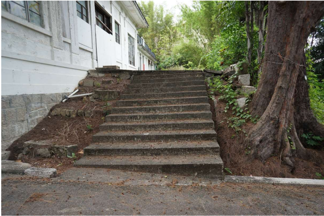
連接南面入口的樓梯的視圖
