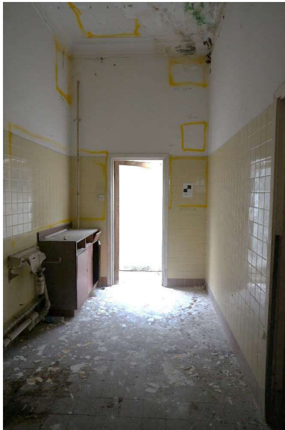
主樓房間1 (地下) (G/F)
