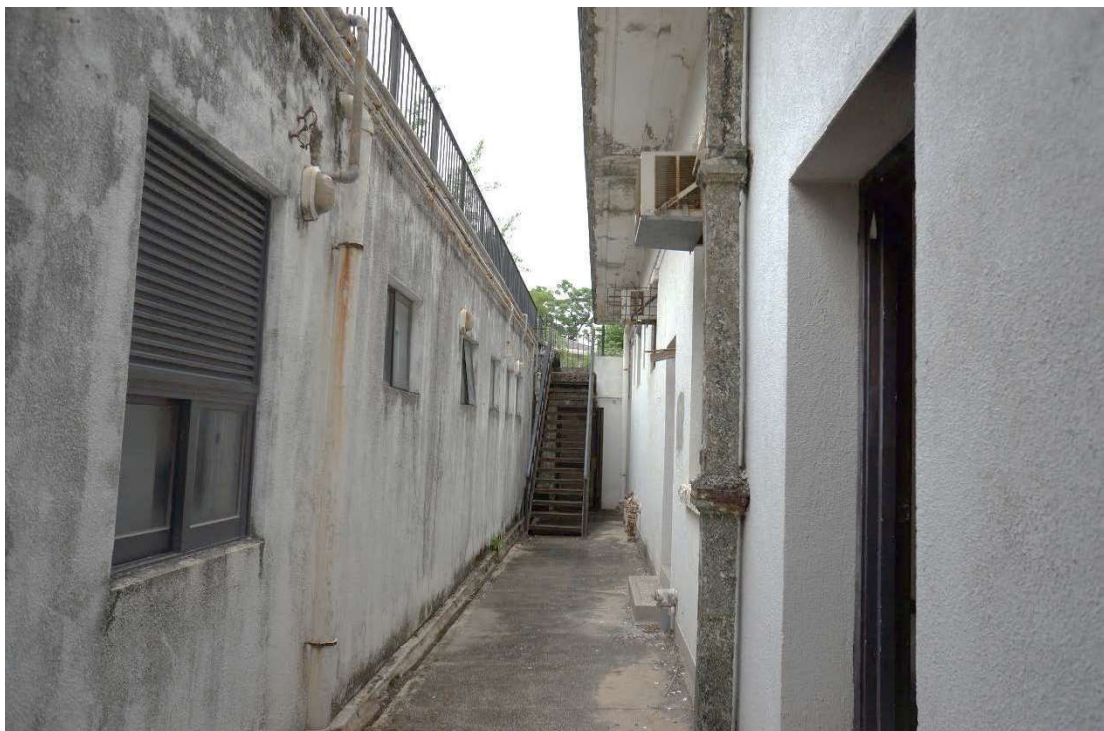
位於主樓與擴建部分中間的天井
