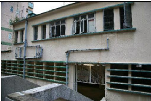
3.2) 裝有鋼筋混凝土格柵和鐵製橫杆的流線型窗戶。
