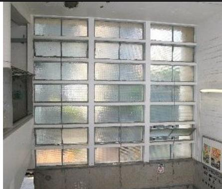
1.5) 位於地下及一樓，裝有混凝土格柵及鐵杆的兩排流線型窗戶。
