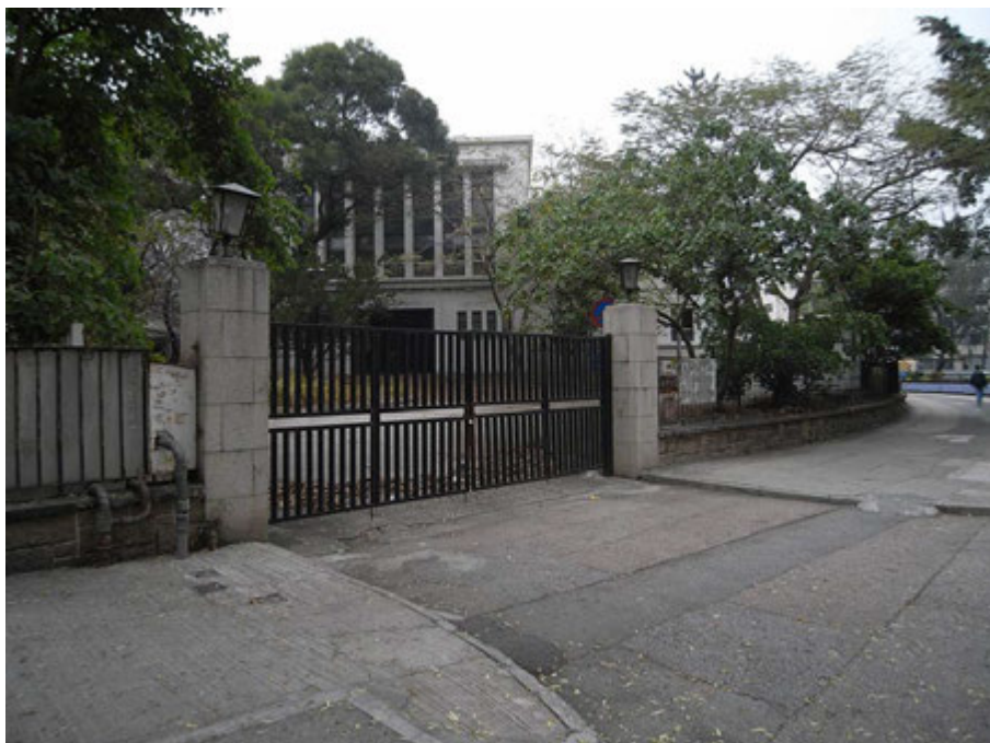
沙頭角公路－龍躍頭段車輛通道入口大閘
