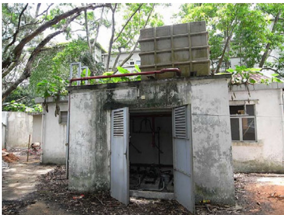
其中一座安放機電設備及水缸的單層建築物，位於當值律師辦公室的旁邊
