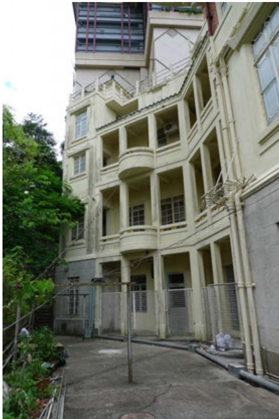
別墅工人宿舍的側立面（向北）
