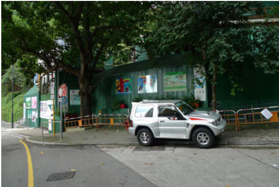
從大坑道望向被圍板圍封的附屬用地
