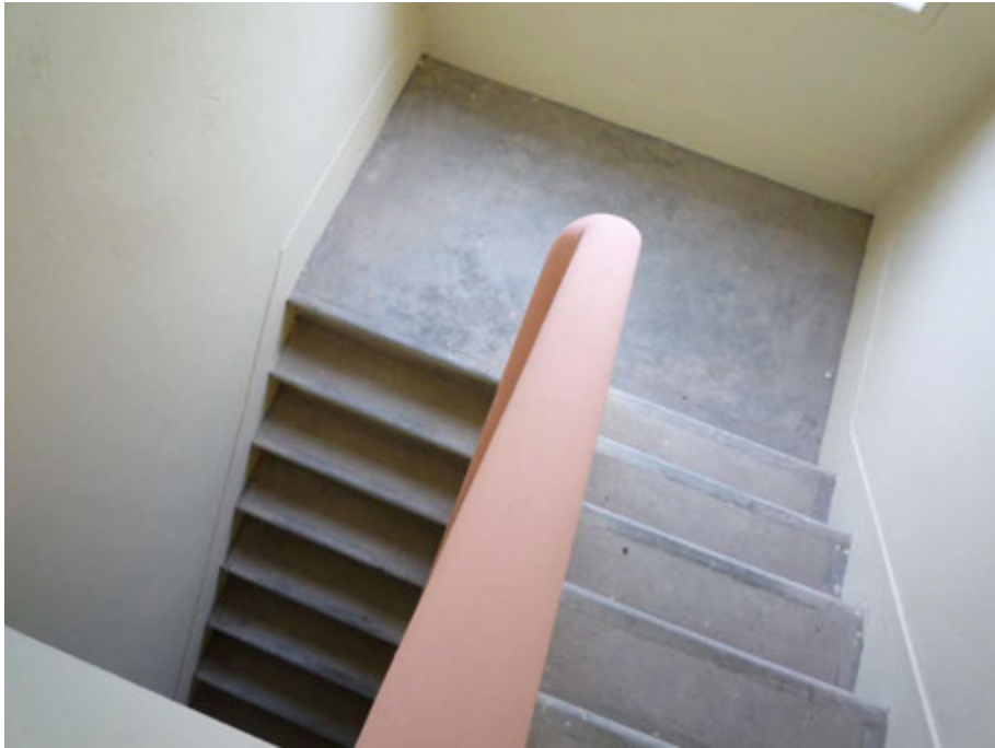
別墅工人宿舍的室內混凝土樓梯
