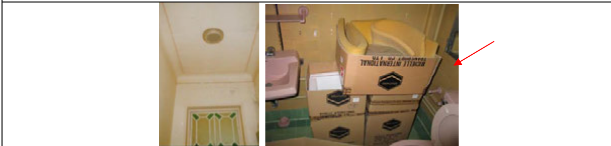
00290 天花照明裝置
