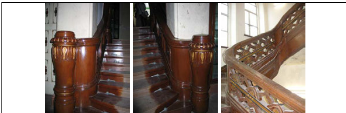
00247 由地面樓層通往天台樓層的樓梯的扶手及護欄
