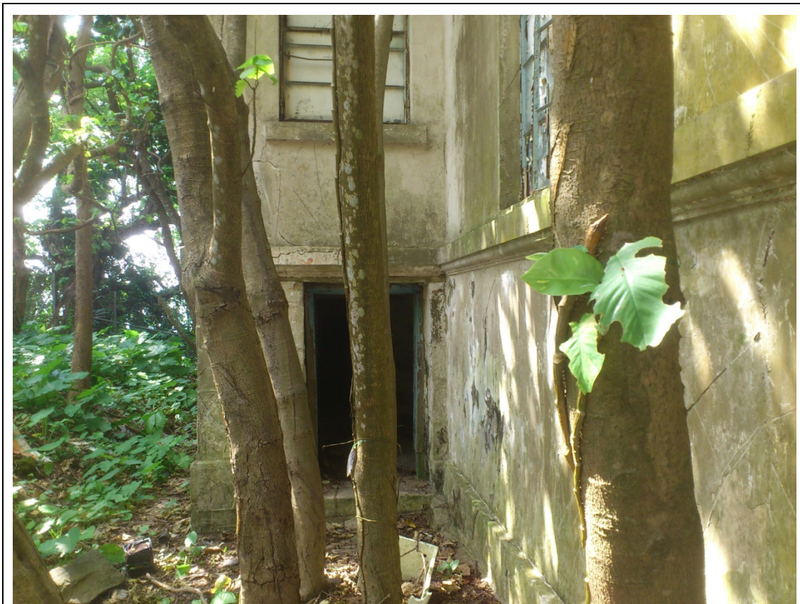
主樓地下樓層的人口
