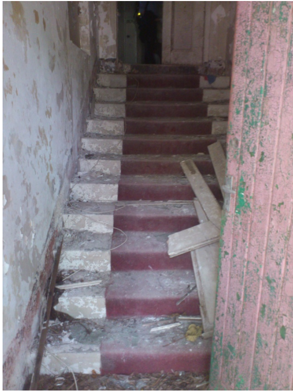
通往主樓一樓樓梯的視圖
