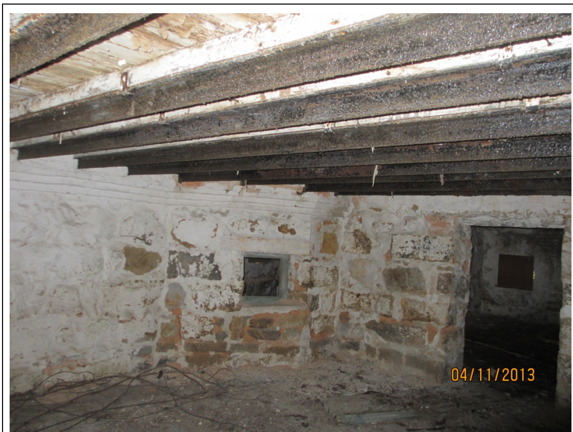
主樓地下樓層的視圖
