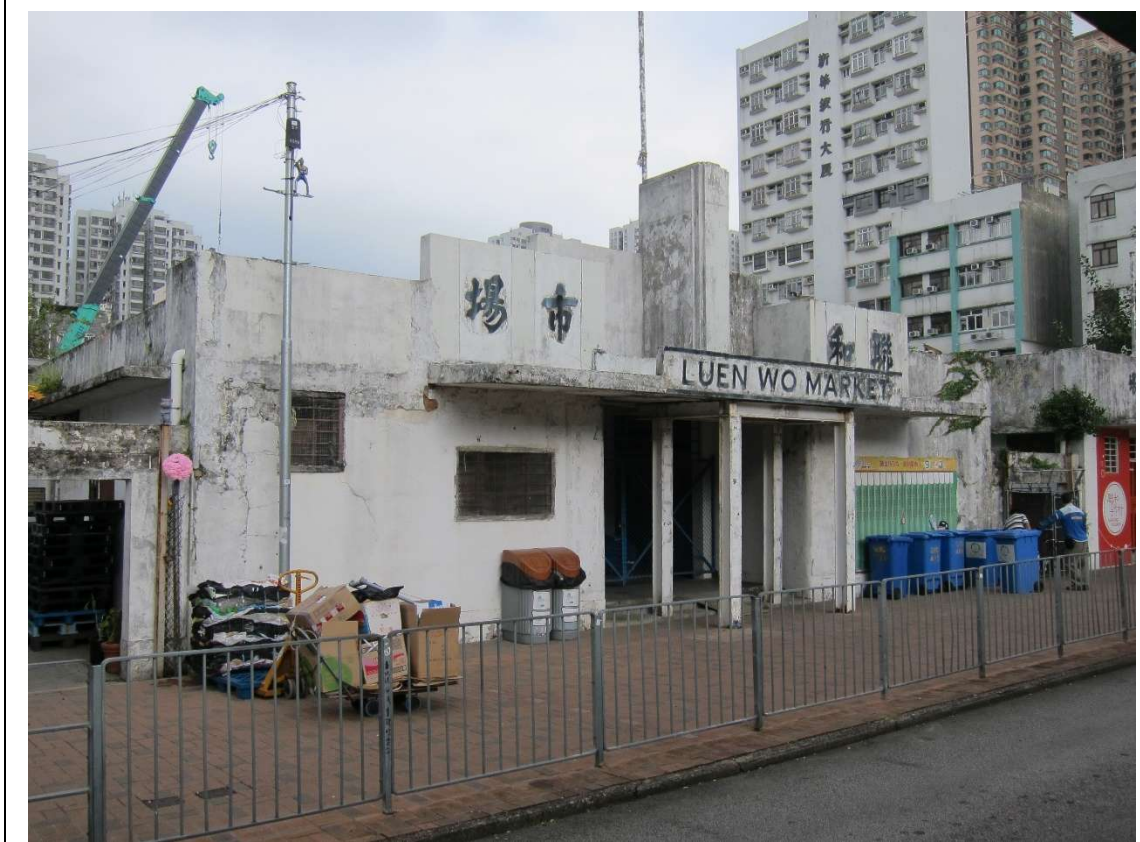
相片 24 主入口的加固結構
