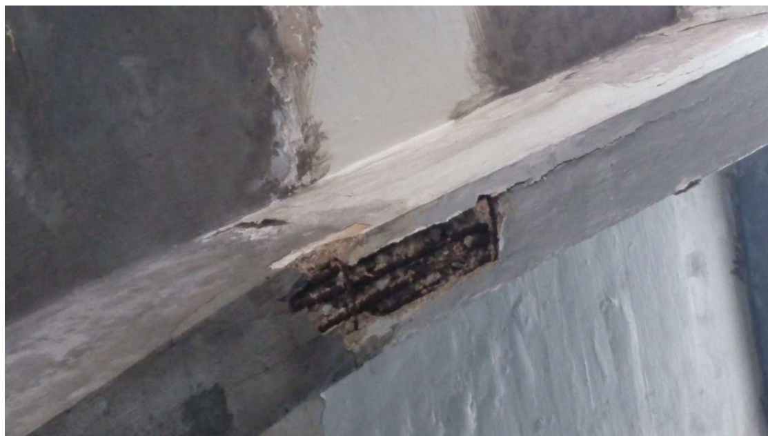
相片 19 樑底混凝土剝落情況(實例)
