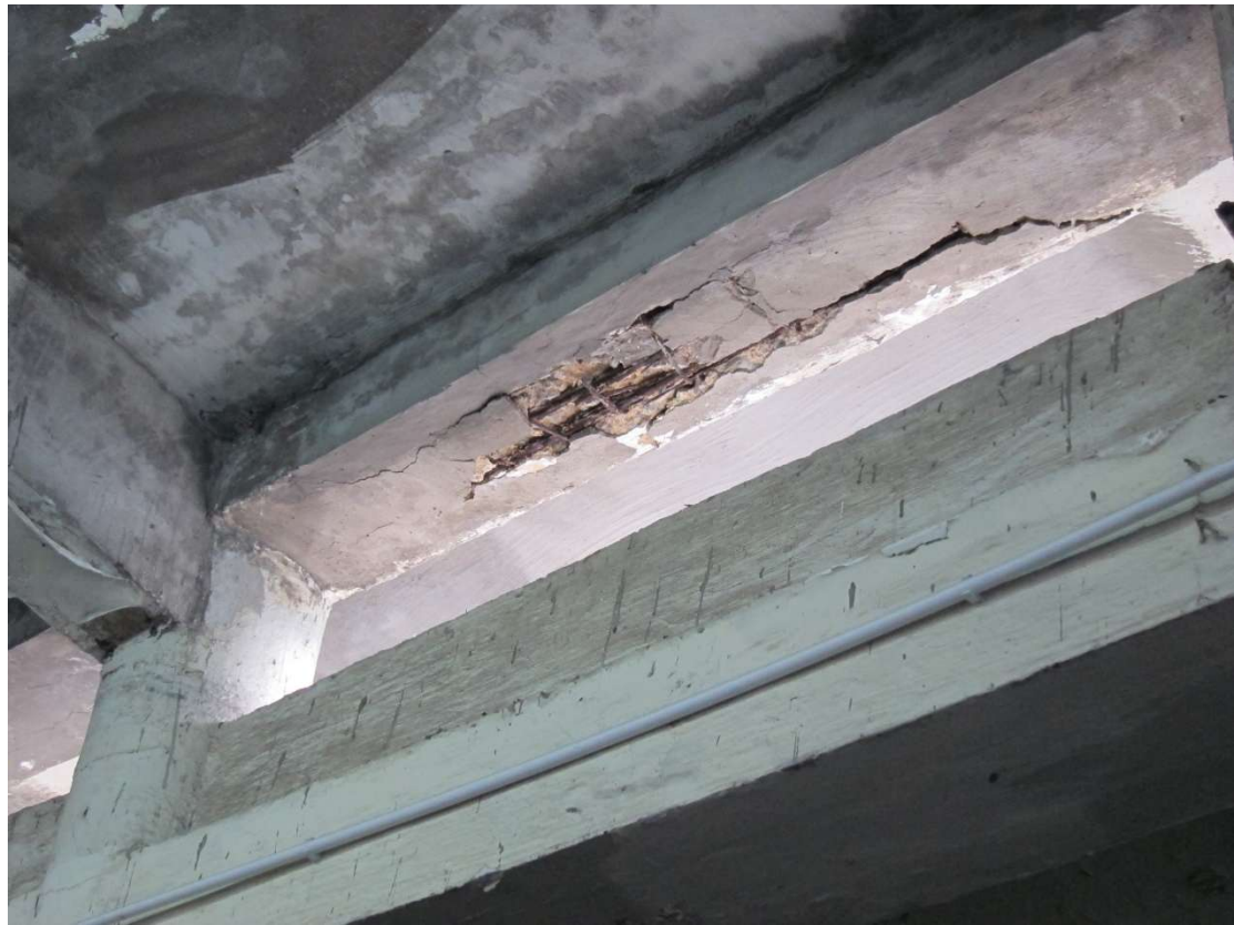
相片 19 樑底混凝土剝落情況(實例)
