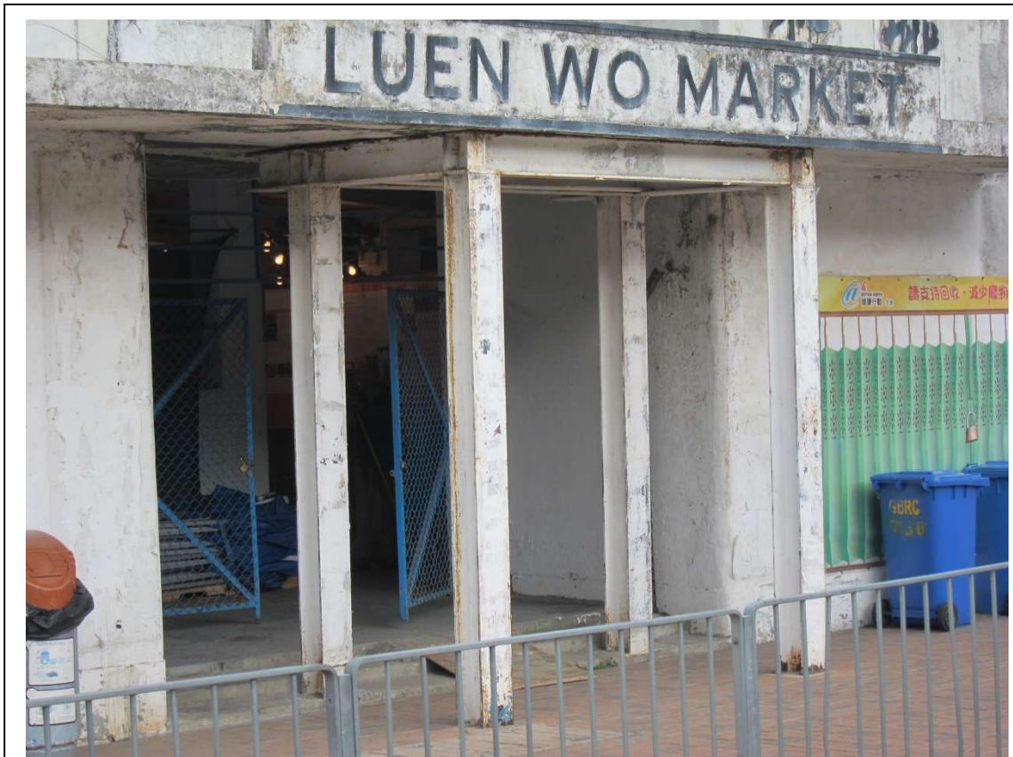
相片 23 主入口的加固結構
