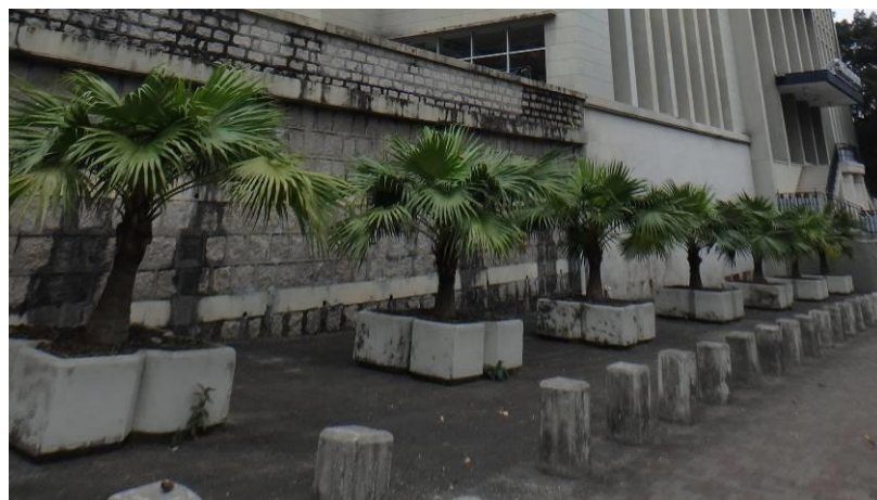
中央一對大樓梯北面的休憩空間
