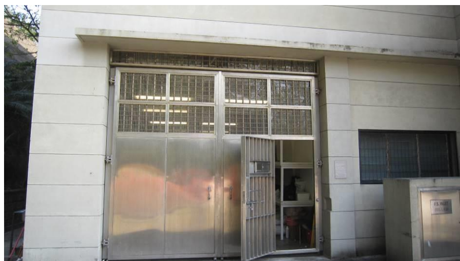
舊警車車房(連舊有金屬閘門)原有的牆壁開口
