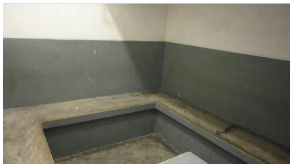
混凝土長櫈及上漆的牆壁飾面連灰色牆裙
