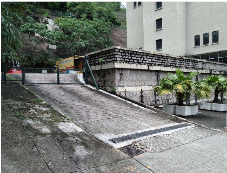
相片編號：12 北面車輛通道
