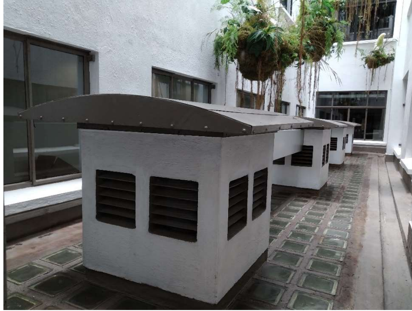
相片編號：25 三樓(3/F)中央天井
