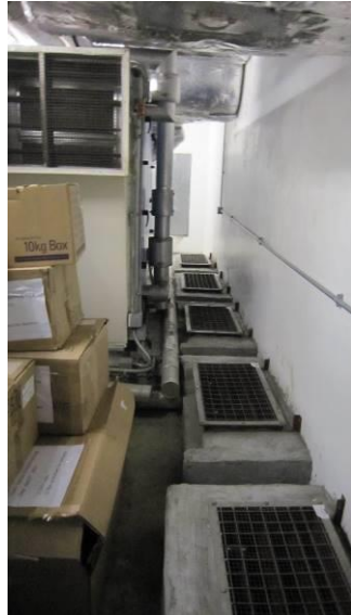
管道房 (格線 A-C)
