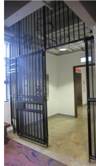
7號舊羈留室的金屬欄柵、格柵及閘門
