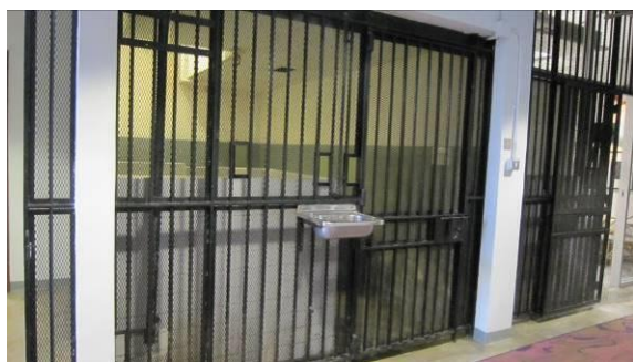
金屬欄柵、格柵、閘門及洗手盆
