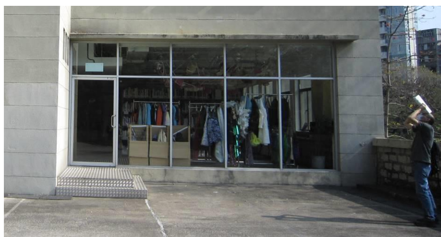
舊裁判官車房原有的牆壁開口
