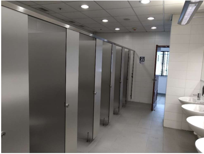
相片編號：29 五樓(5/F)洗手間
