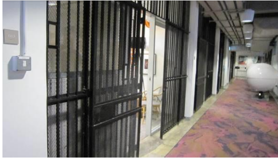
2、3、4、5號舊羈留室的金屬欄柵、格柵及閘門
