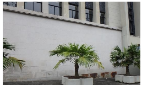
沿地下低層(LG/F)北面建造的簡單琢石鑲面護土牆
