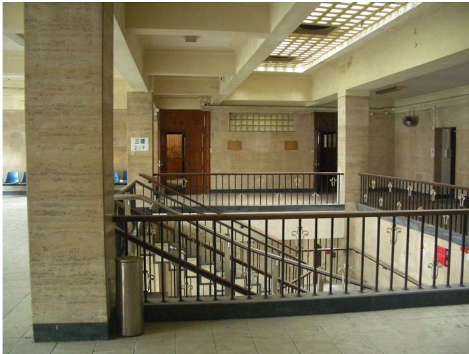
2樓樓梯及其附有裝飾性金屬的欄杆
